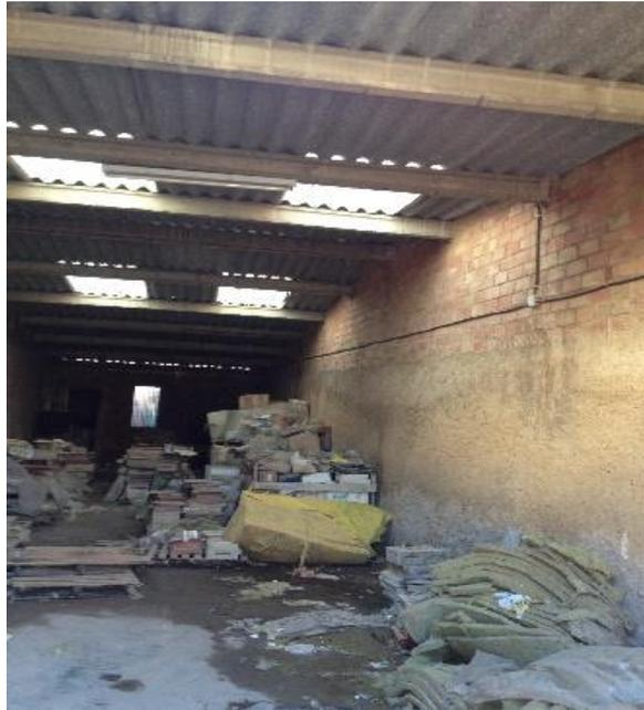
*Vista interior nave, cubierta fibrocemento apoyada en vigueta HA*
