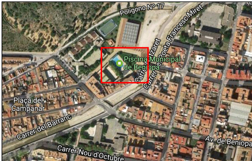
Figura 1: Vista aérea de la situación de la piscina. Fuente: Google Maps
