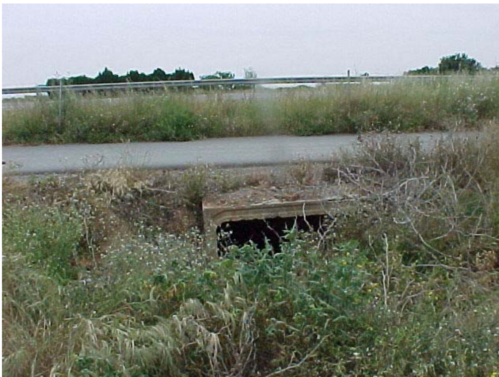
PASO DE CONDUCTO VISTO DESDE LA EDAR
