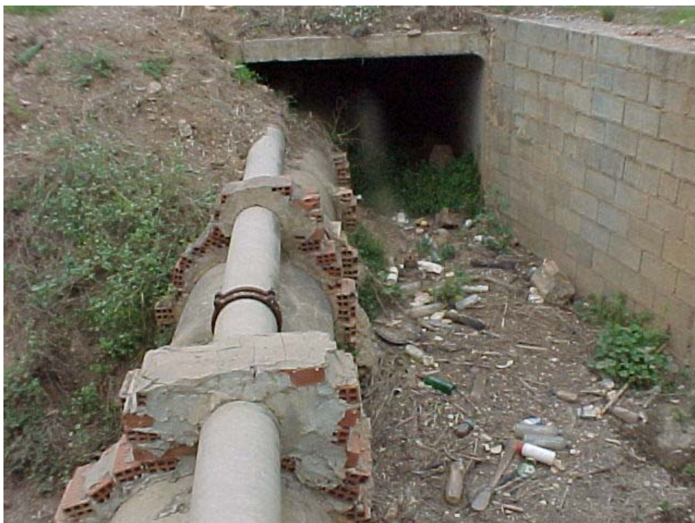
PASO DE CONDUCTO VISTO AL OTRO MARGEN DE LA AUTOPISTA
