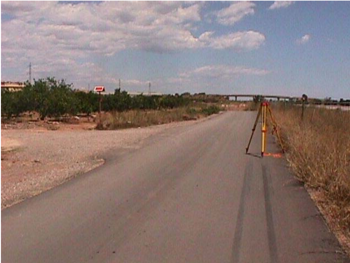
CAMINO ACCESO Y ENTRADA A DEREHAS DE LA EDAR
