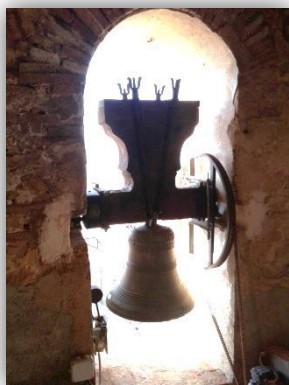
En esta imagen se observa uno de los huecos con campana,
