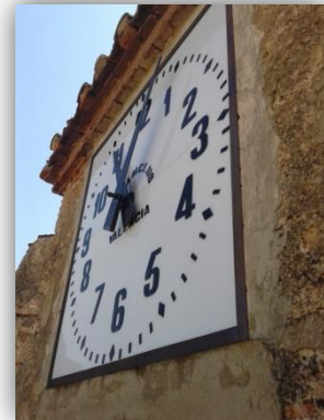
En esta imagen se observa el reloj empotrado en el muro.
