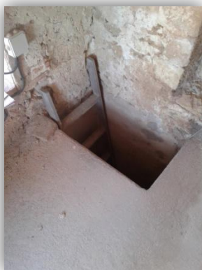
En esta imagen se observa el hueco de acceso a la zona de campanas.
