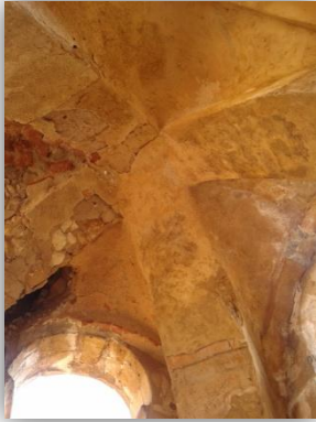
En esta imagen se observa la boveda de aristas que sujetan la cubierta plana y el cuerpo del reloj.
