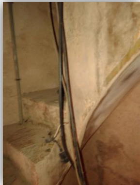
En esta imagen se observa tanto la bóveda como el peldañado de las escaleras.
