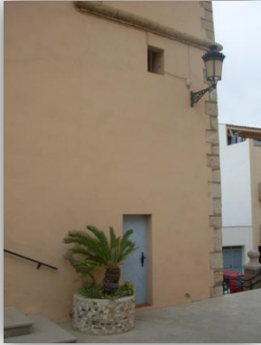
En esta imagen se observa la puerta de acceso al interior de la torre.
