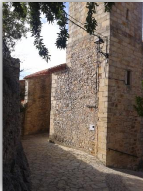
En esta imagen se observa como la cara sureste esta echa con mampuestos y el resto con sillares.
