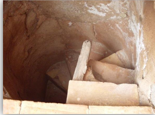
En esta imagen se observan las escaleras de acceso a la cubierta plana.
