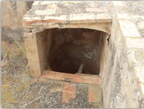
En esta imagen se observa el casetón que cubre las escaleras de acceso a la cubierta.
