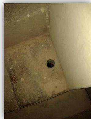
En esta imagen se observa el agujero por el que anteriormente se pasaban las cuerdas para hacer sonar las campanas.
