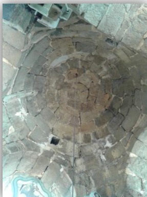
En esta imagen se observa el techo de la zona de campanas el cual se trata de una bóveda de pechinas.
