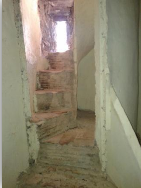
En esta imagen se observa la escalera de caracol que da acceso a la zona de campanas más grandes y a la zona del reloj.
