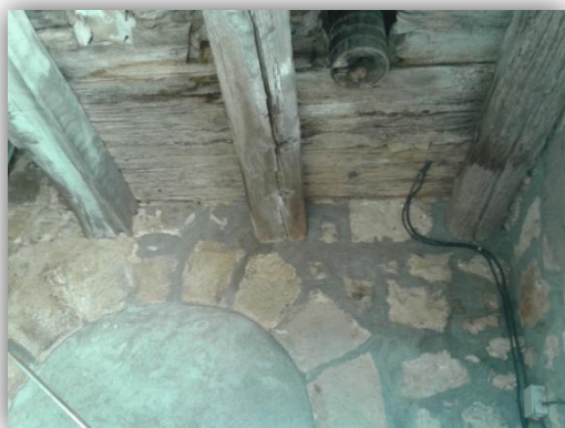
En esta imagen se observa el forjado que sujeta la estancia del reloj.
