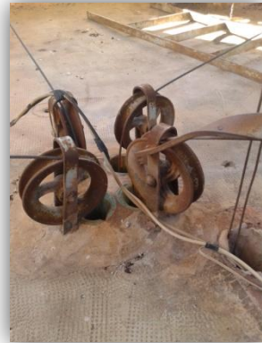
En esta imagen se observan las poleas por las que va el cable para hacer sonar las campanas.
