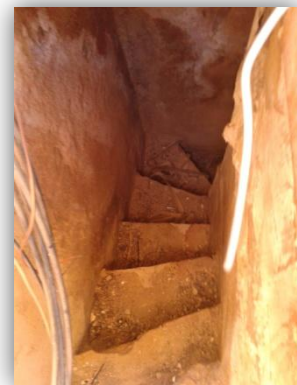
En la foto se observa la zona de paso de escaleras que queda en la zona de reloj.
