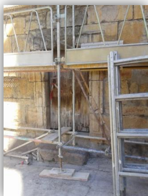
En esta imagen se observa la puerta de acceso a la torre campanario.
