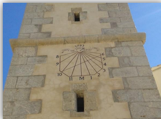
En la imagen se observa los huecos que iluminan el interior de las escaleras, la cornisa que separa el basamento de la zona del reloj y el reloj de sol, que se encuentra en la fachada principal.
