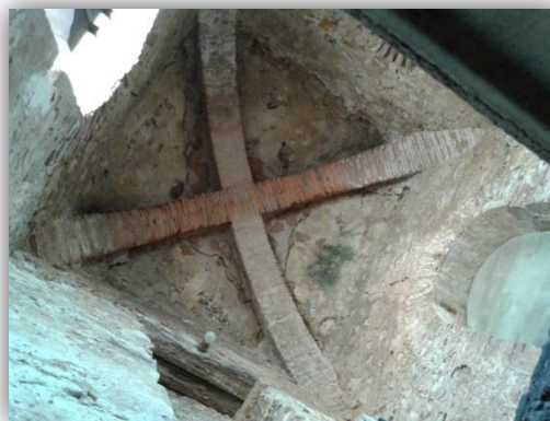
En esta imagen se observa la baveda de sujeción de la cubierta con sus aristas bien definidas.
