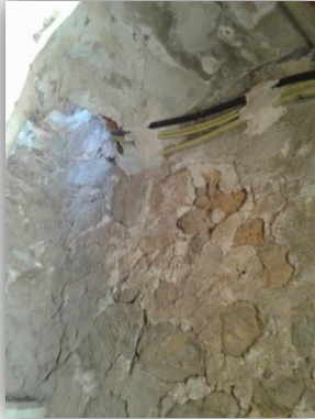
En esta imagen se observa el hueco por el que se accedía a la zona de campanas superior.
