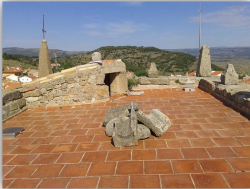
En esta imagen se observa la cubierta plana, el casetón de acceso con la cubierta inclinada y los ornamentos que hay por encima del peto de la cubierta.
