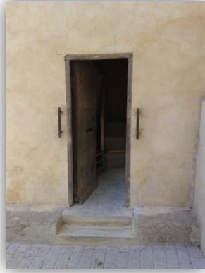
En esta imagen podemos observar la puerta de acceso al interior de la torre.
