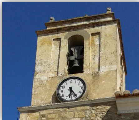
En esta imagen se observa el hueco de la fachada principal, debajo del cual se encuentra el reloj.
