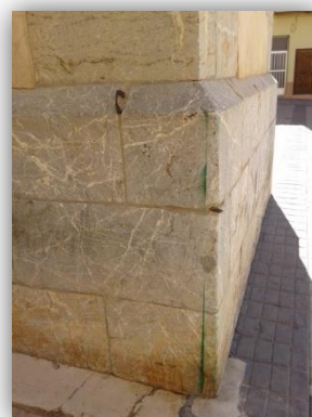
En la imagen se observa el zocalo exterior de la torre
