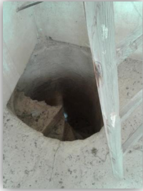
En esta imagen observamos la llegada de la escalera de caracol a la zona del reloj.
