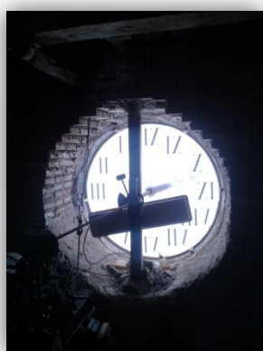
En esta imagen se observa la esfera del reloj por el interior, también se observa como la estancia está construida con ladrillos de barro.
