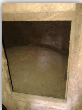
En esta imagen se observa la ventana existente para acceder a la bóveda que forma el techo de la capilla.
