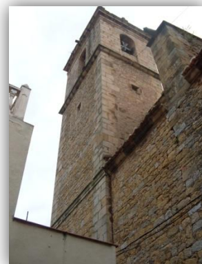
En esta imagen se observa la zona norte y oeste de la torre.
