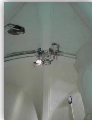
Bóveda de aristas, forjado suelo zona de campanas.
