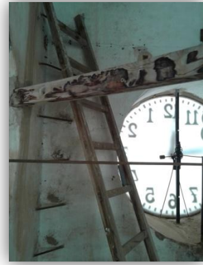
En esta imagen se observa el reloj por el interior y la escalera para subir a la zona de campanas intermedia.
