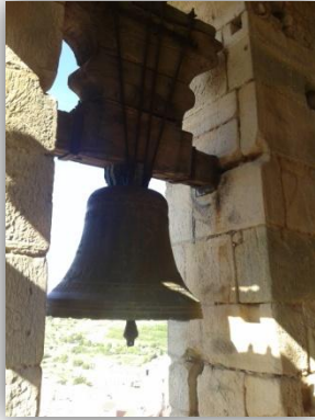
En esta imagen se observa una de las campanas, con armazón de madera.
