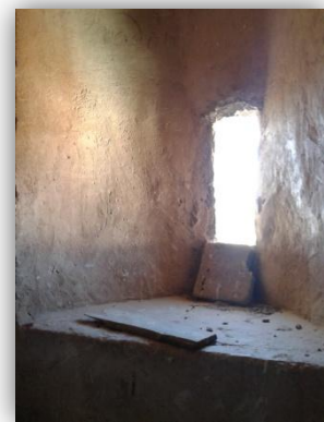
En la imagen se observa el hueco que hay para iluminar las escaleras.
