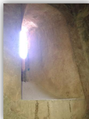
En esta imagen se observa uno de los huecos existentes para iluminar las escaleras
