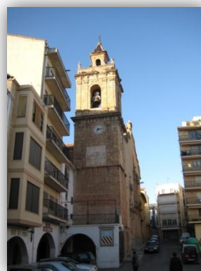
En esta imagen se observa la cara sur-oeste del campanario.
