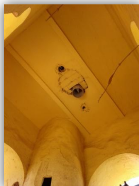
En esta imagen se observa el forjado de la zona del reloj.
