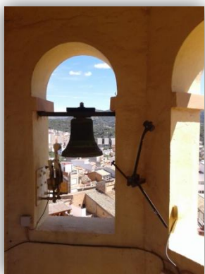
En esta imagen observamos uno de los huecos de la zona de campanas intermedia con su campana y los elementos para hacerlo sonar.
