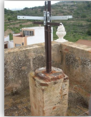
En esta imagen se observa el peto de la cubierta, el solado de baldosas de barro una cruz en el centro encima de una pilastra y el ornamento que hay en cada uno de los ángulos de la cubierta.
