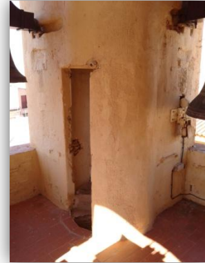
En esta imagen se observa la escalera por fuera y el acceso a zona de campanas.
