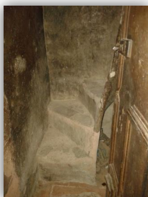
En esta imagen se observa el arranque de las escaleras.
