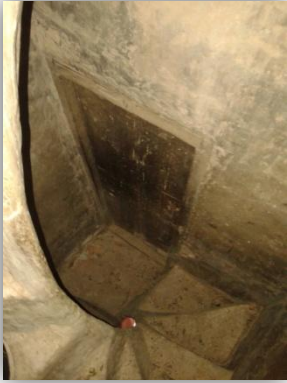
En esta imagen se observa la puerta que da acceso a la sala del antiguo reloj.
