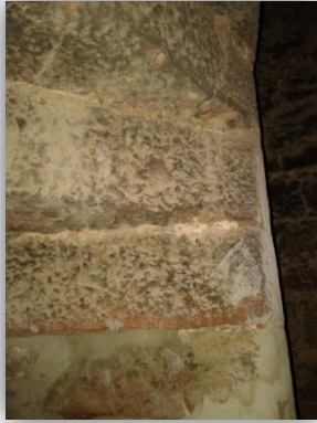
En esta imagen se observan las escaleras vistas desde abajo.
