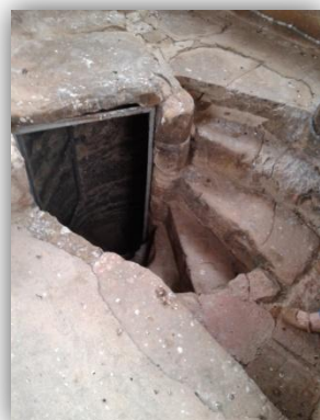
En esta imagen se observa la llegada de las escaleras a la zona de campanas.
