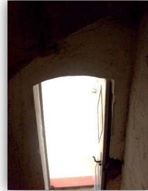
En esta imagen se observa la puerta de acceso desde el interior de la misma.
