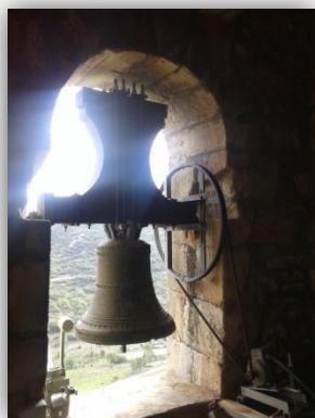
En esta imagen se observa uno de los dos huecos de la zona de campanas con su correspondiente campana.
