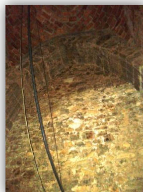
En esta imagen se observa la bóveda de pechinas que sujeta el piso de la estancia del antiguo reloj.
