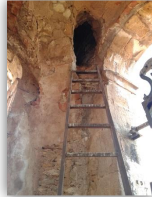
En esta imagen se observa la escalera de gato por la que se accede al cuerpo de reloj y a la cubierta.
