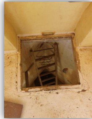
En esta imagen observamos la trampilla por la que se accede a la zona de campanas intermedia.
