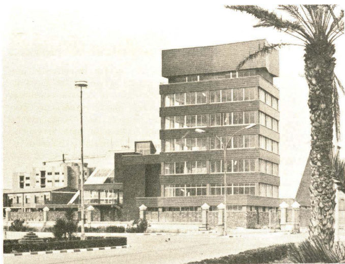
Nuevo edificio de la Cooperativa del Mar, de la Cofradía de Pescadores, en el Grao.
