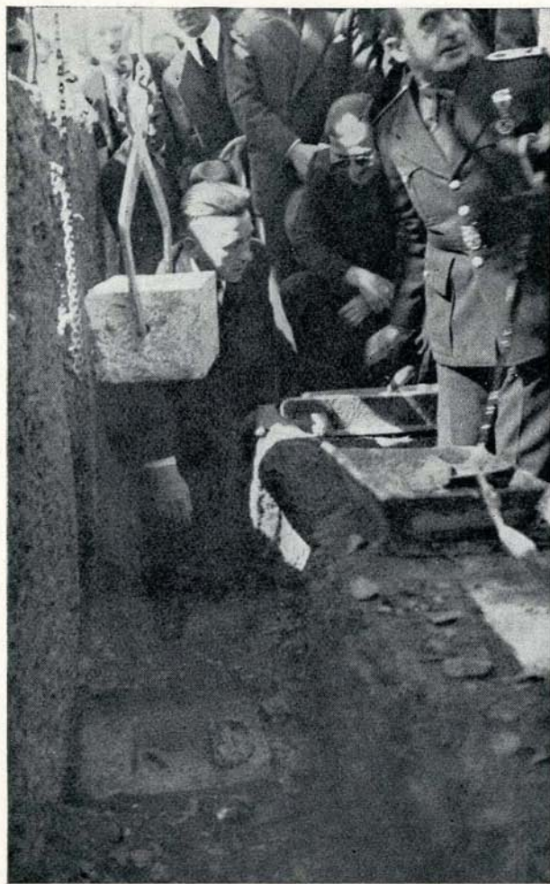
Momento de la colocación de la primera piedra
