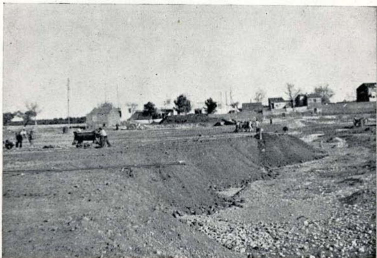
Un aspecto del movimiento de tierras, que da idea del volumen de dichos trabajos
