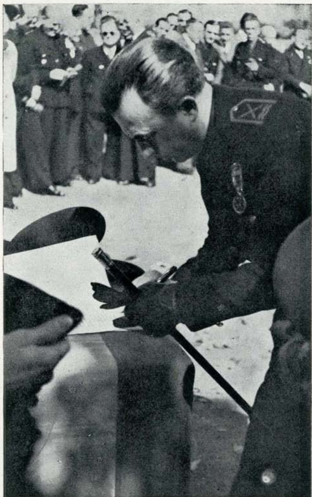
El Excmo. Sr. D. José Andino Núñez, Jefe Provincial del Movimiento y Gobernador Civil de la Provincia, firmando el acta de colocación de la primera piedra del Estadio
