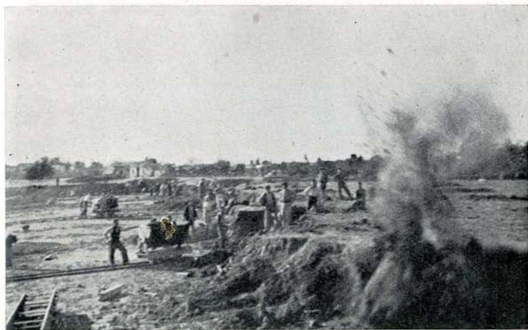
Otro aspecto de movimiento de tierras
