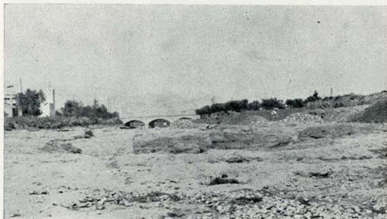
Vista del cauce del río Seco, parcialmente ocupado por las obras
