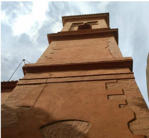
Los muros de la torre se componen por sillares en la base como cimientos y ladrillo cerámico en el resto.
