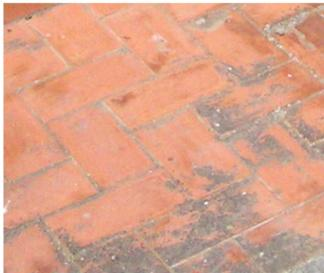
En cuanto al pavimento destacan el baldosín catalán de la cubierta plana. Se aprecia que fue colocado con posterioridad a su construcción. Ya que no era típico de su época. En el resto de la torre lo compone el propio mortero de la capa de compresión de los diferentes elementos.
