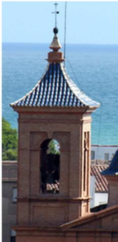
En el último tramo de la torre se encuentra una cubierta de teja cerámica curva, con tonalidad azul y blanca en los bordes, a cuatro aguas con una ligera curvatura, en forma de pirámide. Volando una cierta distancia para proteger del agua de lluvia.
