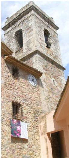
El cuerpo de basamento, adosado a la Iglesia, se compone por muros de mampostería, excepto las esquinas que se ha realizado con piedra de sillería, de mejor calidad. Ya que las esquinas son puntos más susceptibles al desgaste. Ambos se encuentran rejuntados con mortero de cal.
