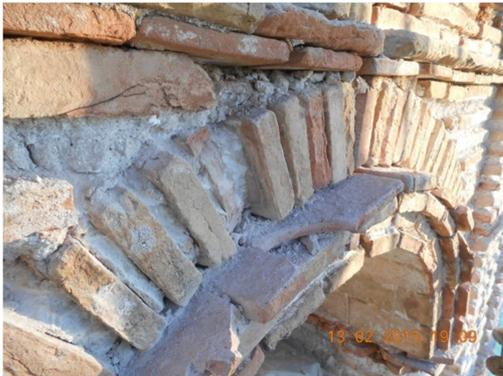
En el cuerpo de campanas se describen cuatro arcos de medio punto de ladrillo tabicado doble, aunque en su parte superior están en forma de rosca. El soporte de la primera cubierta y de la elevación del templete es soportado por una cúpula, además de vigas de arriostramiento. El remate posee base octogonal junto a ocho aperturas de arcos de medio punto, constituidos por ladrillo tabicado doble.
