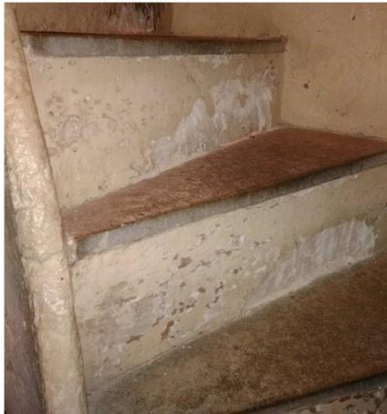
Las caras interiores del muro de ladrillos se encuentran revestidas con yeso, no así la planta de campanas revestido con mortero de cal en tonalidades tierra.
