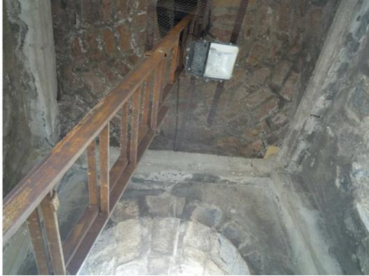
La escalera de acceso a las diversas plantas de la torre, es una escalera realizada de bóveda tabicada apoyada sobre el borde interior del muro, realizada con ladrillo cerámico, recibida con mampuestos para la forma de peldaños. Se encuentra revestida de yeso por su cara inferior.
