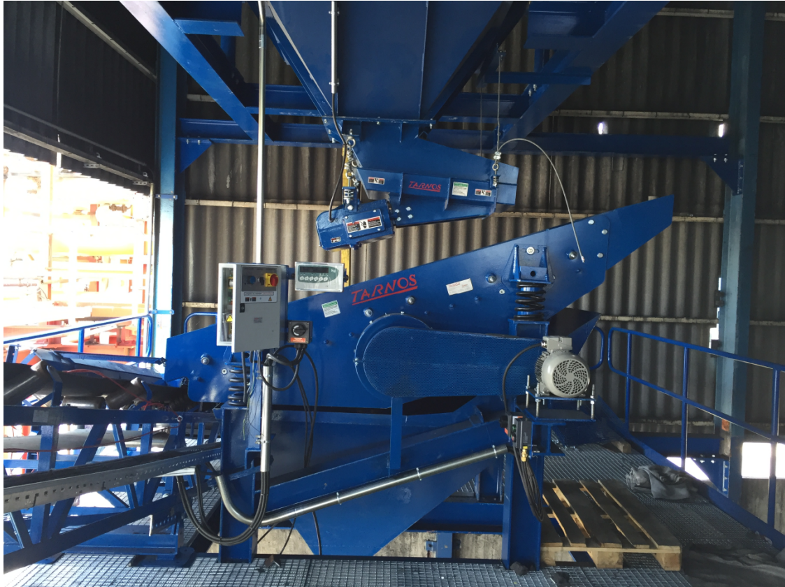
Ilustración 8. Descarga de material desde la tolva hasta la criba
