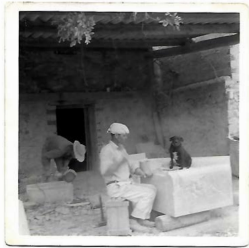
Preparant la motllura a una peça per a la frontera d'un panteó. Any 1967 // Propietat: José María Bernad
