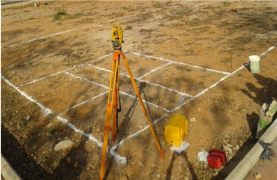
Imagen 3: Procedimiento del replanteo. Fuente propia
