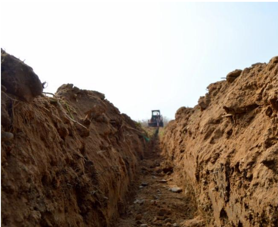
Imagen 4: Apertura de zanjas para sistema de riego. Fuente: Internet ( http://golfterramar.com )
