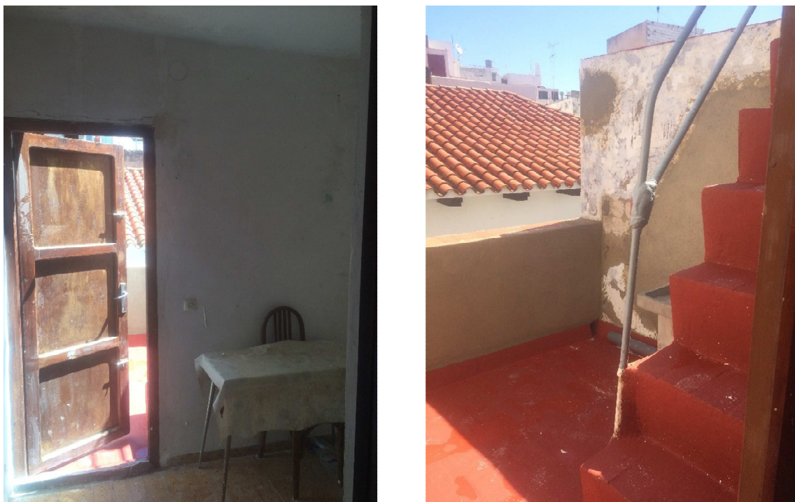
Puerta de acceso a la terraza y escalera que da acceso a la cubierta – Planta Bajo Cubierta
