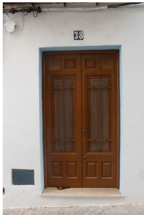
Puerta de entrada a la vivienda
