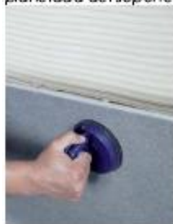
Instalación de la baldosa cerámica
