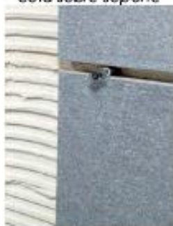
Fijación del anclaje de seguridad
