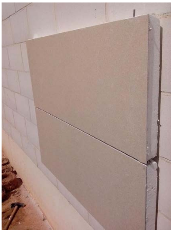
Imagen 77 – Instalación SATE cerámico
