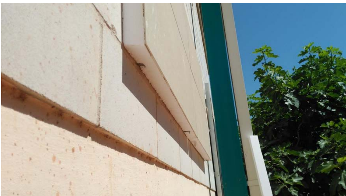
Imagen 79 – Instalación SATE cerámico
