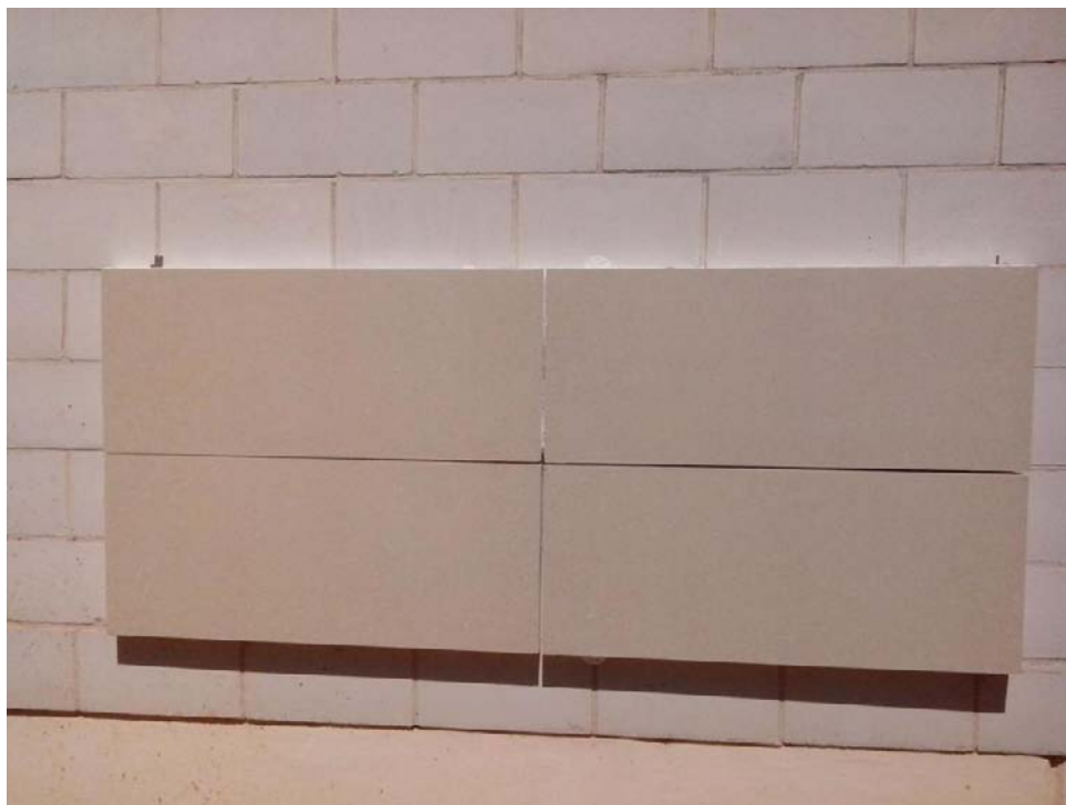
Imagen 80 – Instalación SATE cerámico
