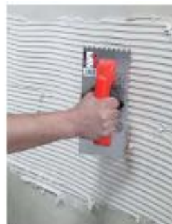
Peinado del cemento cola sobre el soporte
