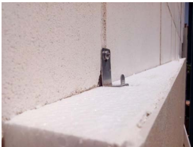
Imagen 78 – Instalación SATE cerámico
