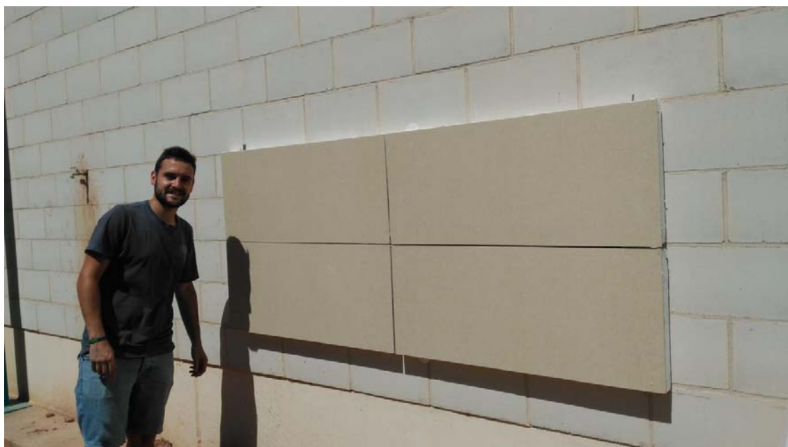
Imagen 81 – Instalación SATE cerámico
