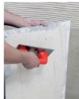
Doble encolado en el dorso de la baldosa
