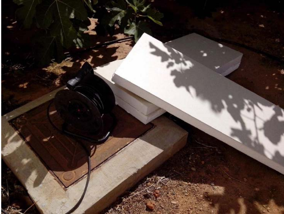
Imagen 74 – Instalación SATE cerámico
