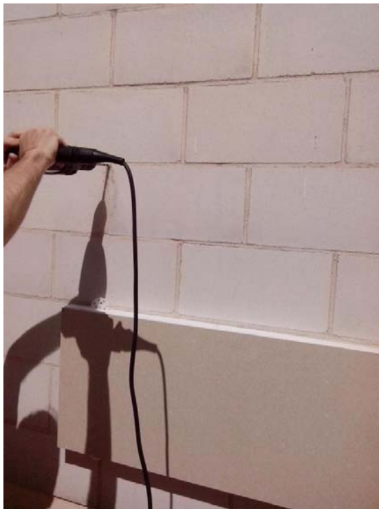
Imagen 76 – Instalación SATE cerámico
