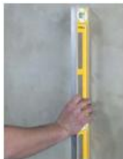
Comprobar la planeidad del soporte
