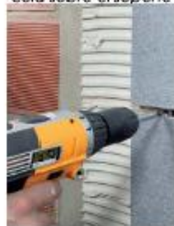
Apriete del anclaje de seguridad
