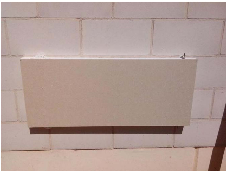
Imagen 75 – Instalación SATE cerámico
