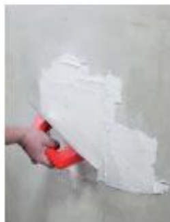
Aplicación del cemento cola sobre soporte
