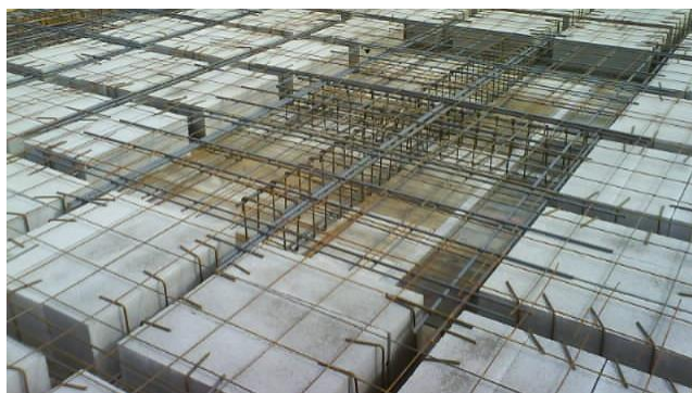
Ilustración 2.10: Forjado reticular con casetón de hormigón
