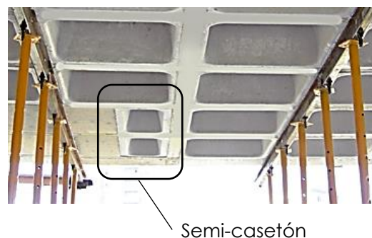
Ilustración 2.15: Ej. de colocación de semi-casetón
