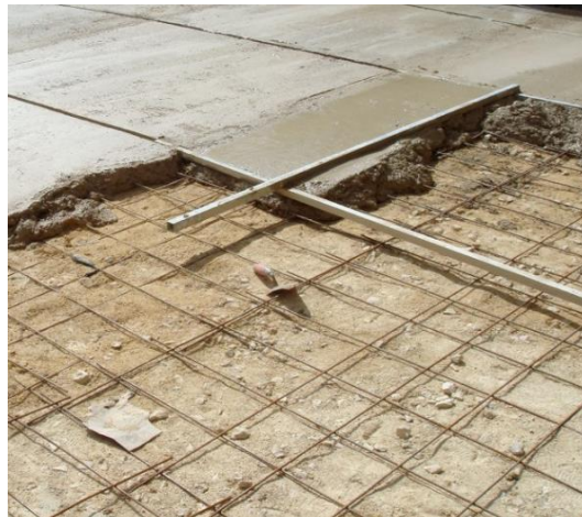
Ilustración 2.5: Armadura de reparto durante su colocación
