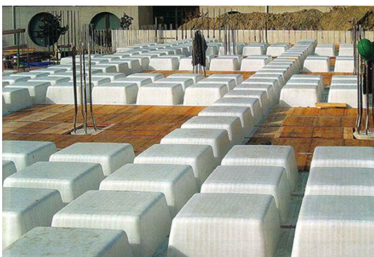
Ilustración 2.12: Forjado con casetón recuperable
