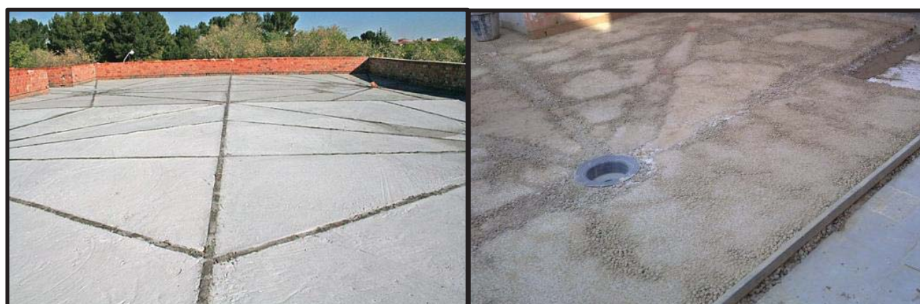
Figures 12 i 13: ( www.obrasonline.com ; emetreseme-estudio.blogspot.com ) Resultat de la formació de pendents una volta retirades les regles metàl·liques i reomplert el buit. Resultat final una volta regularitzat tota la superfície i preparada per a rebre la impermeabilització.
