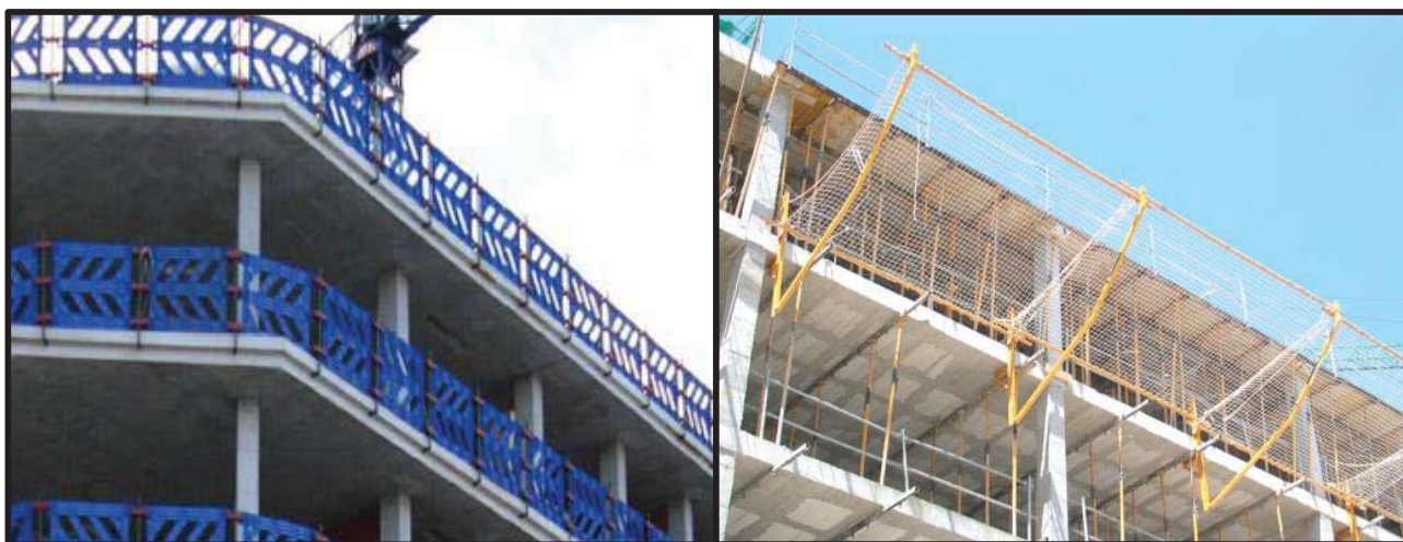
Figures 64 i 65: ( www.systemasafety.com , www.lineapreencion.com ) Equips de protecció anticaigudes col·lectius: el primer actiu (evita la caiguda) i el segon passiu (deté la caiguda).
