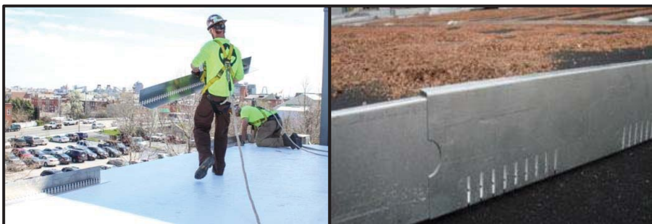
Figures 40 i 41: ( furbishco.com , www.projar.es ) Procés de col·locació dels perfils de separació de materials, amb la part horitzontal en direcció a la part enjardinada; i detall del perfil amb ranures per a la circulació de l'aigua.
