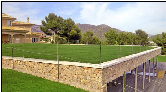
Figura 7.8 - ( www.zinco-cubiertas-ecologicas.es ): Coberta vegetal intensiva amb gespa. Encara que el gruix del sistema es reduït, aquesta coberta requereix molt de manteniment i per tant es considera intensiva.
