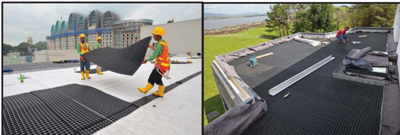
Figures 38 i 39: ( www.triton-chemicals.co.uk , squarespace.com ) Procés de col·locació de la capa drenant mitjançant plaques rígides i resultat final, acabant en els perfils de separació de materials i llastant aquests.
