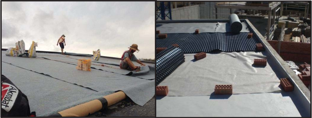
Figures 34 i 35: ( www.okambuva.coop , www.singulargreen.com ) Procés de col·locació de manta retenidora mitjançant rotllos amb solapament. En les dues imatges es pot observar el llast que s'ha col·locat durant l'execució.
