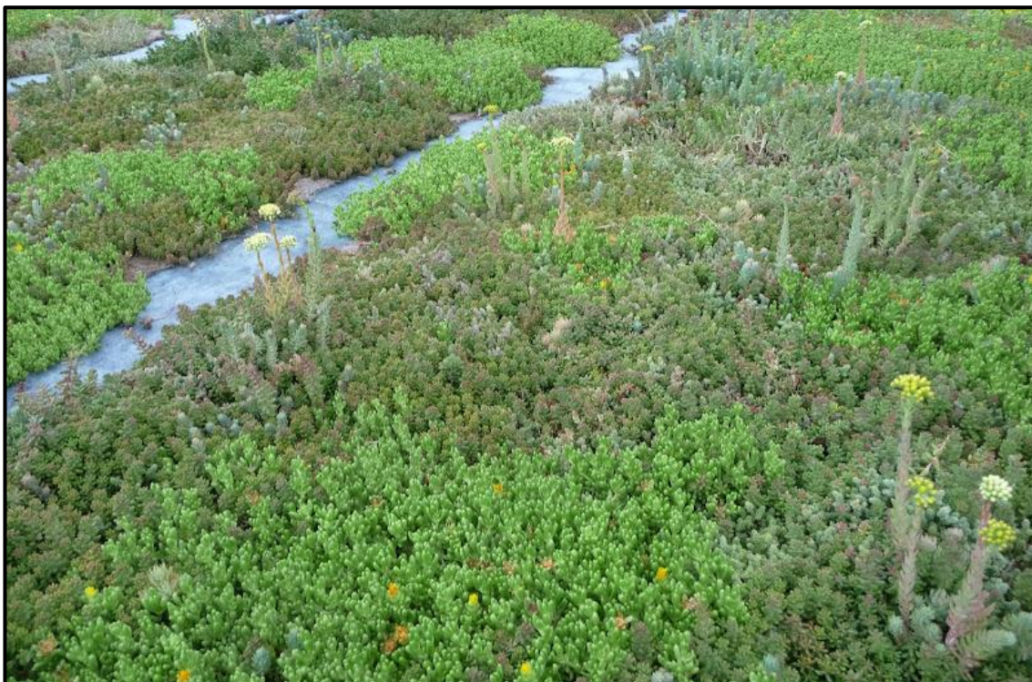
Figura x i x: ( www.alicanteforestal.es ) Coberta amb Sedum tapiant, com es pot observar, la cobertura es total i l'espessor suficient per a produir els efectes positius que es busquen en la capa vegetal de la coberta.
