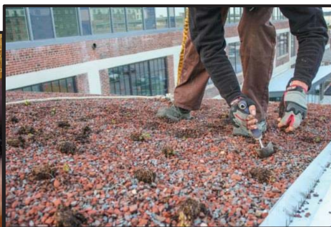
Figures 56 i 57: ( www.greenroofplants.com , furbishco.com ) Fotografia d'un plantó sa, amb bona quantitat d'arrels i fullatge. Procés de plantació de plantons amb paleta menuda.
