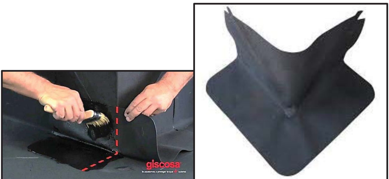
Figures 18 i 19: ( www.youtube.com , www.cubimat.com ) Procés de col·locació de peça prefabricada per a cantons exteriors i detall de la peça.
