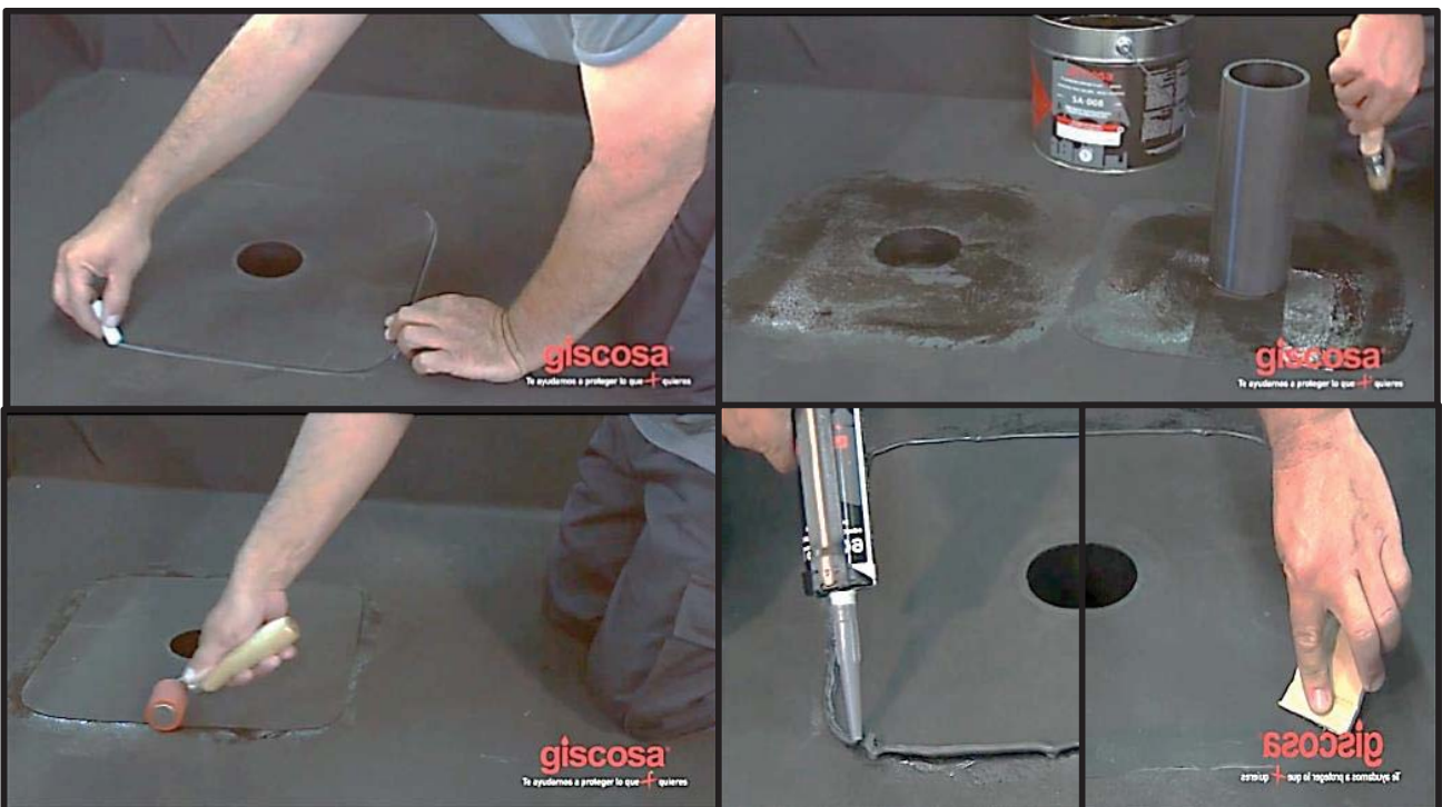
Figures 24 a 28: ( www.youtube.com ) Procés de col·locació d'un desguàs prefabricat sobre lamina d'EPDM.
