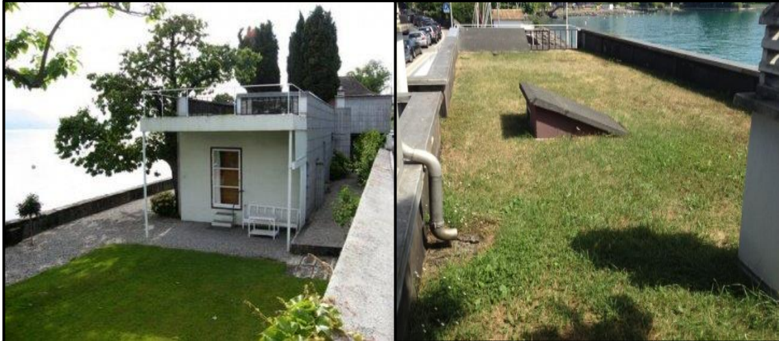
Figures 6.15 i 6.16 ( wikiarquitectura.com ; www.pinterest.com ) Ville Le Lac , construïda en els anys 1923-1924 per l'arquitecte Le Corbusier a Corsaux (Suïssa).
