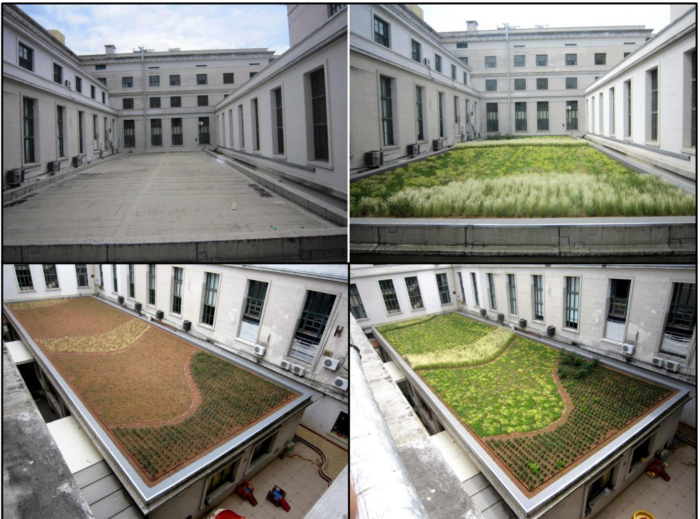
Figures 11.14 a 11.17: ( cubiertaverde.wordpress.com ) Obra realitzada a la Facultat de Dret de la Universitat de Buenos Aires, amb una superfície de 406m 2 i 15cm de substrat. Té 4 tipus de sedum i 2 tipus de suculentes. Va ser instal·lada al 2013.
