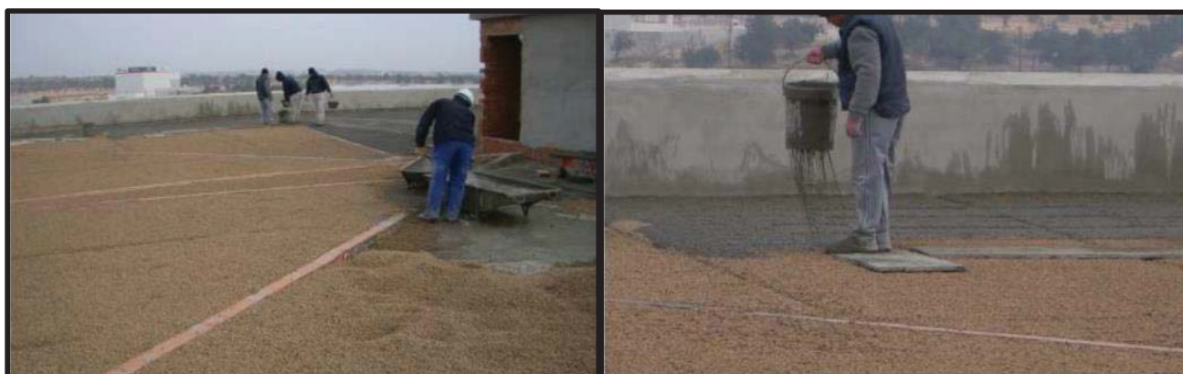
Figures 10 i 11: ( www.five.es ) Procés d'execució de la formació de pendents, abocament de l'argila expandida en sec i regat superficial amb abeurada de ciment, sobre taulons de fusta.
