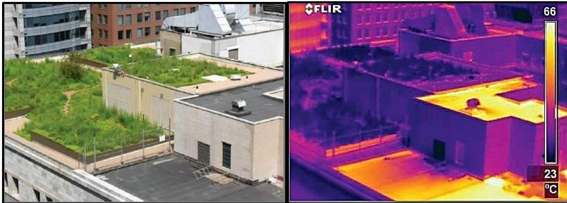
Figures 11.1 i 11.2 ( www.pthorticulture.com ) : Foto de l'esquerra : Sostre Verd de Chicago City Hall Font: Informe de Pla d'Acció pel Clima de Chicago. Foto de la dreta: Imatge infraroja del sostre verd de l'Ajuntament Chicago amb tecnologia de detecció de calor, mostra en un dia típic, el sostre verd Ajuntament Chicago és de fins a 43°C més fred que el sostre convencional contigu.
