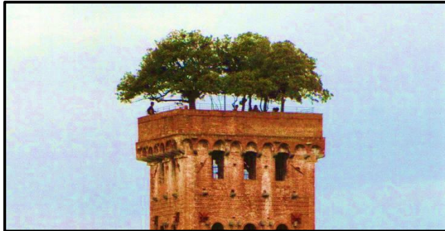
Figura 6.8 ( www.tuscany-villas.es ) Coberta de la Torre Guinigi (Lucca, Itàlia) construïda al 1834 i a la que es va afegir en els s.XIII o XIV una coberta vegetal amb set roures. La torre i la coberta són visitables pels turistes. Imatge 360º: www.hvweb.net
