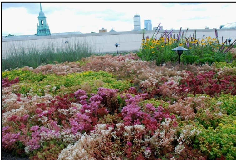
Figures 7.3 i 7.4 - ( www.paimed.com ; myrooff.com ): Coberta vegetal semi-intensiva a Itàlia i coberta vegetal semi-extensiva amb plantes aromàtiques.
