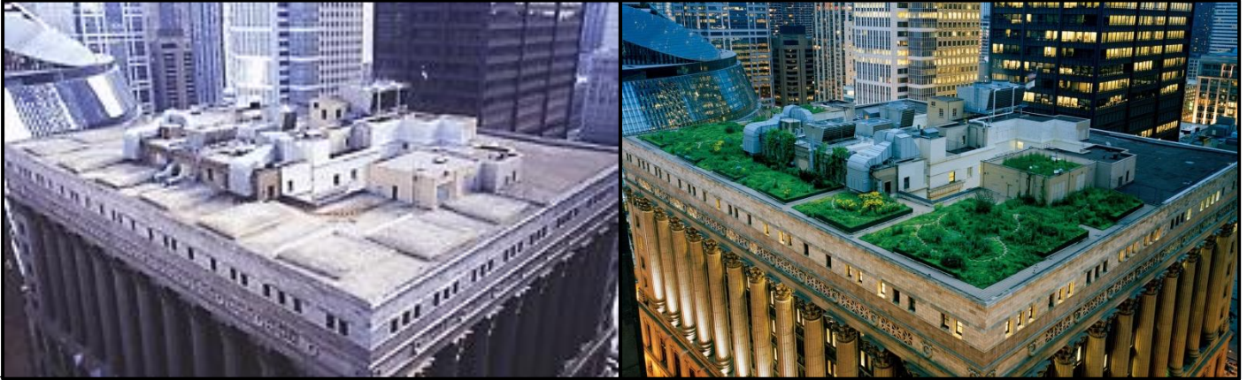
Figures 11.12 i 11.13: ( landscapeonline.com ; urbanmatter.com ) Ajuntament de Chicago (EUA), abans i després de la instal·lació d'una coberta vegetal.
