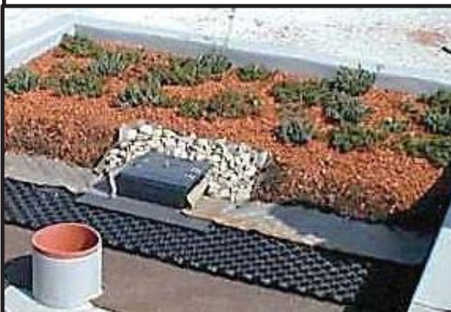
Figures 43 i 44: ( ignasiconillas.com , www.certificadosenergeticos.com ) Gràfic i fotografia on s'observa la ubicació de la capa filtrant, entre el substrat i la capa drenant.
