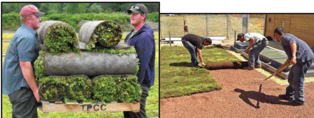
Figures 54 i 55: ( www.sedummaster.com , furbishco.com ) Procés de col·locació de vegetació mitjançant mantes de vegetació
