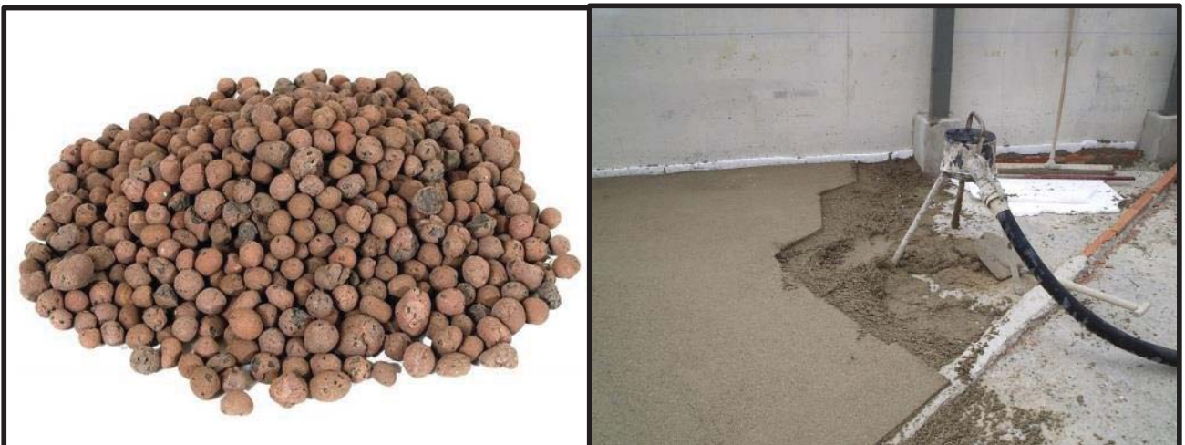
Figures 6 i 7: ( www.servovendi.com , www.geora.es ) Argila expandida en sec (la granulometria és de 8 a 20 mm). Sistema d'elevació d'argila fins a la coberta.
