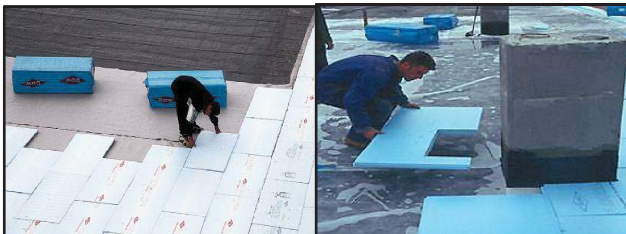
Figures 31 i 32: ( img.archiexpo.com , building.dow.com ) Procés de col·locació de l'aïllament tèrmic amb peces completes, a trenca juntes, i peces tallades a mida.
