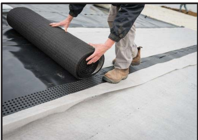
Figura 46: ( www.construible.es ) Fotografia que mostra la col·locació d'un drenatge que porta adherit el filtre, facilitant la instal·lació de dues capes en un sol pas. Com es pot veure el filtre té excés per un dels costats, per tal de crear el solapament corresponent després de desenrotllar el producte.
