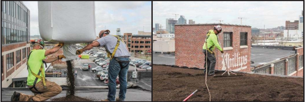
Figures 47 i 48: ( furbishco.com ) Procés d'abocament del substrat mitjançant big bag i d'extensió d'aquest per la coberta de forma regular.
