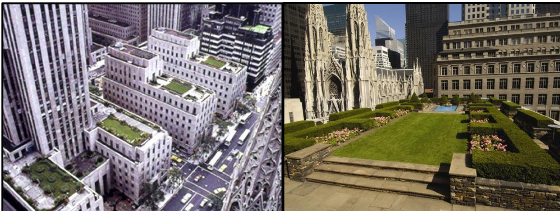
Figures 6.17 i 6.18 ( www.greenroofs.com ; strawberrymilkevents.com ) Rockefeller Center , construït el 1936 per l'arquitecte Raymond Hood a Nova York (Estats Units d'Amèrica), compta amb una coberta intensiva.
