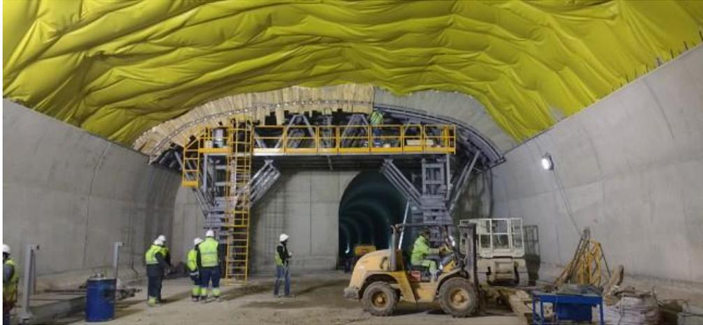
*Imagen 1. Equipo de encofrado revestimiento túnel. Propiedad de Concreta Desarrollo S.L.*
