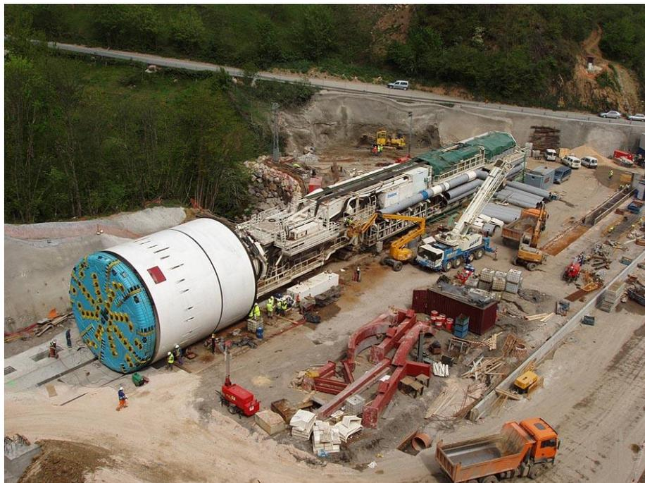
*Imagen 35. Tuneladora TMB*
