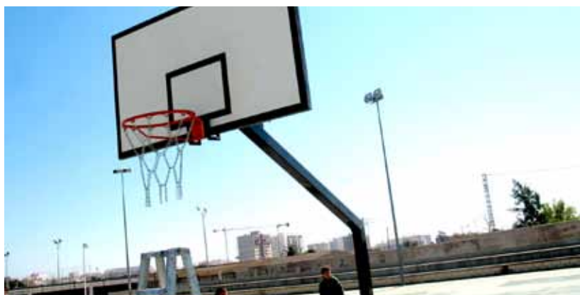
Millora de les quatre cistelles de les pistes esportives
