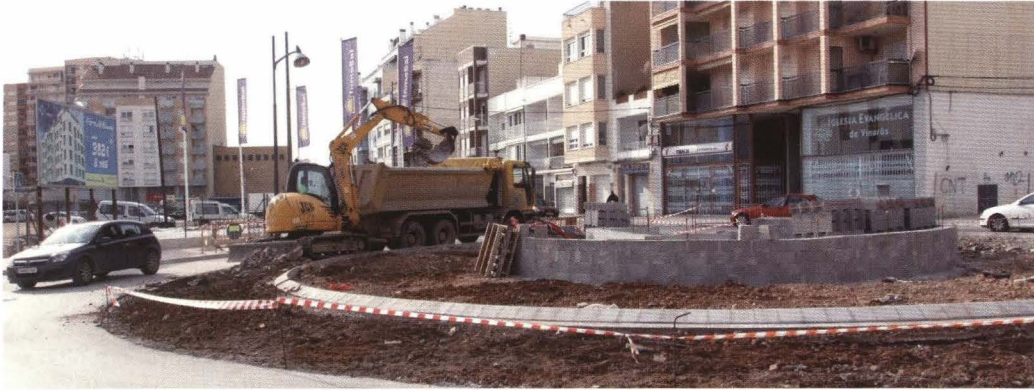
La rotonda, en obres
