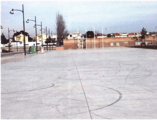
El cobriment de la pista annexa al pavelló poliesportiu costarà 400.000€
