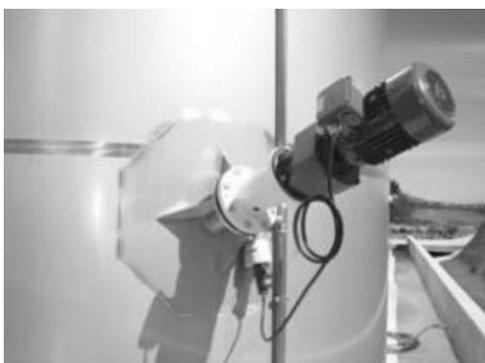
*Ilustración 20 - Instalación en un digestor de un agitador de montaje lateral*
