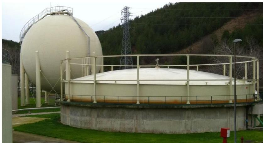
*Ilustración 5 - Digestor anaerobio y gasómetro de una EDAR*
