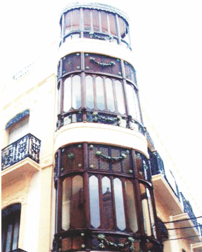
■ La façana modernista de l'emblemàtica casa Angel Giner llueix en tot el seu esplendor després de la seua restauració.
