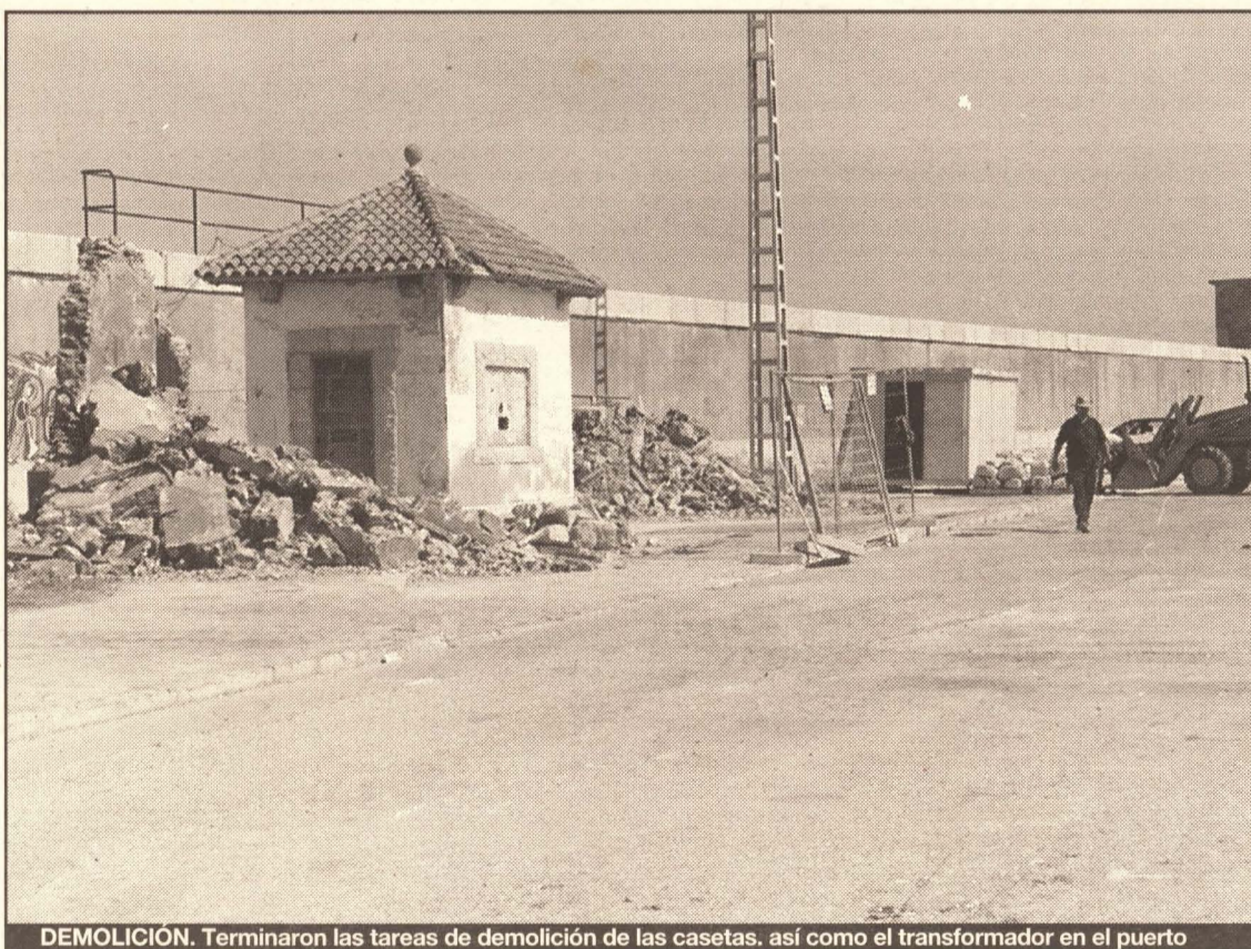
DEMOLICIÓN. Terminaron las tareas de demolición de las casetas, así como el transformador en el puerto
