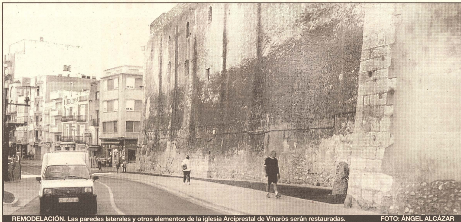
REMODELACIÓN. Las paredes laterales y otros elementos de la iglesia Arciprestal de Vinaròs serán restauradas.
