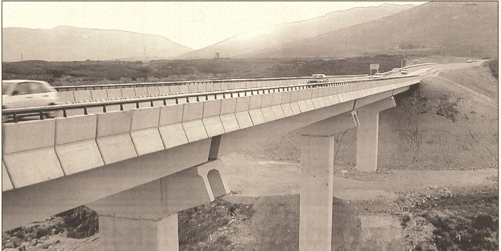
ESPECTACULAR. La construcció de l'espectacular pont i l'ampliament de la calçada és un obra de gran envergadura per a la nostra ciutat.
