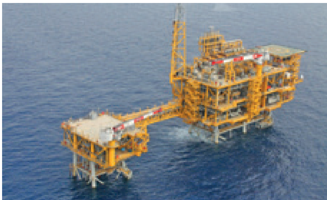
Vista de la plataforma marina del proyecto Castor
