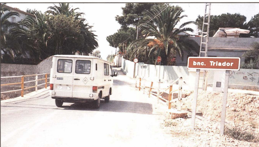
▲ La Generalitat Valenciana ha adjudicat les obres del barranc del Triador
