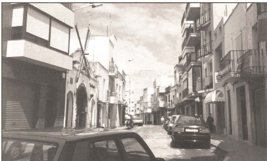
Calle de San Gregorio donde se instaló nueva iluminación. Foto: A. Alcázar
