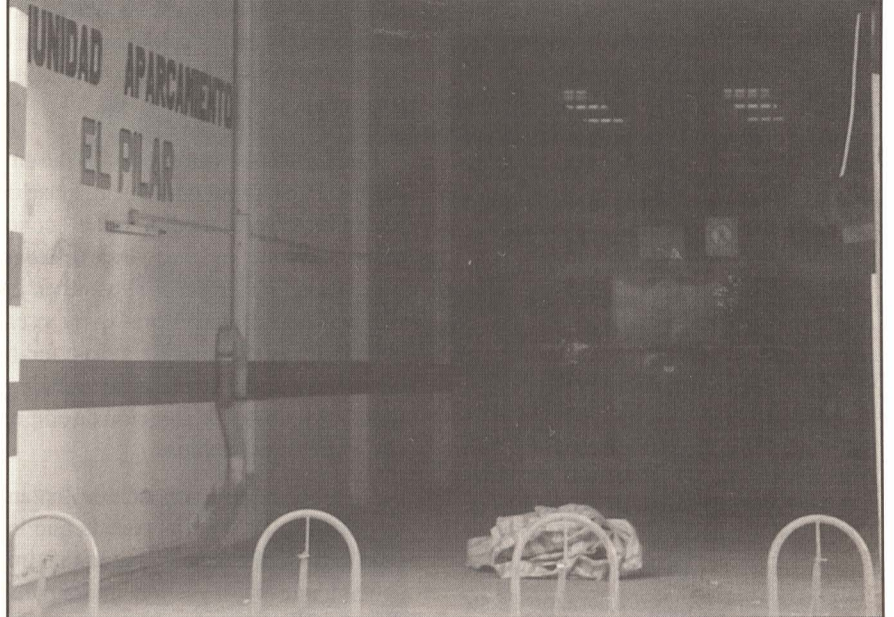
Entrada del aparcamiento El Pilar. Foto: A. Alcázar
