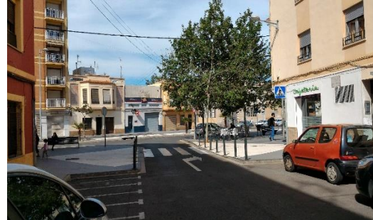
Ilustración 65. Edificios por la parte de la Avenida Quevedo
