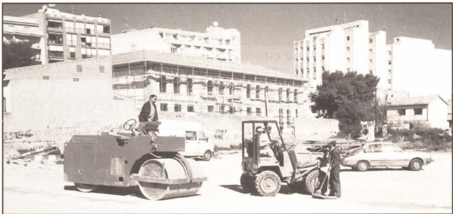
Varias calles de Vinaròs han sido dotadas de una capa asfáltica, entre ellas, EL CID, LLUÍS SANTAPAU, SAN FERNANDO. Además de la carretera de ELS COSSIS junto al Río Cervol. Foto: A. Alcázar
