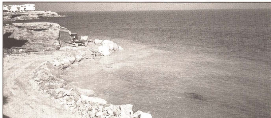
Estado actual de las obras de un tramo de la Costa Norte. Foto: A. Alcázar
