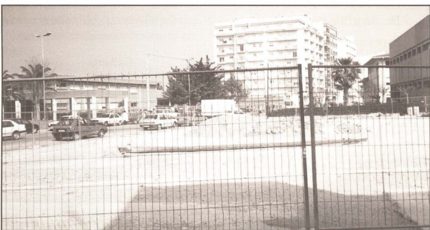
Solar donde se construirán los nuevos juzgados de Vinaròs.
