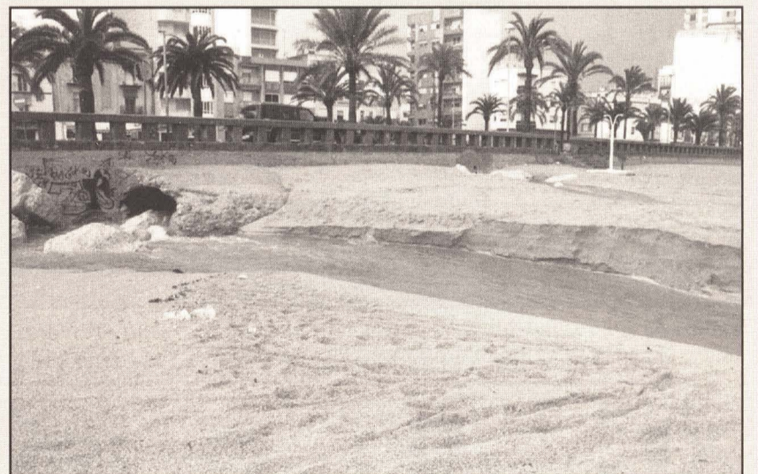
Las fuertes lluvias atacan directamente a la platja del Fortí, por las aguas que llegan con fuerza desde la Plaza de San Valente, entre otras. ¿Se desviará hacia el río Cervol algún día esta cloaca? Justamente está casi enfrente de la nueva Oficina de Turismo
