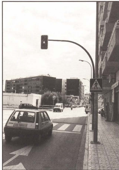
La senyal indicativa de Paso de peatones tapa por completo las luces del semáforo en su parte inferior. Foto: Difo's
