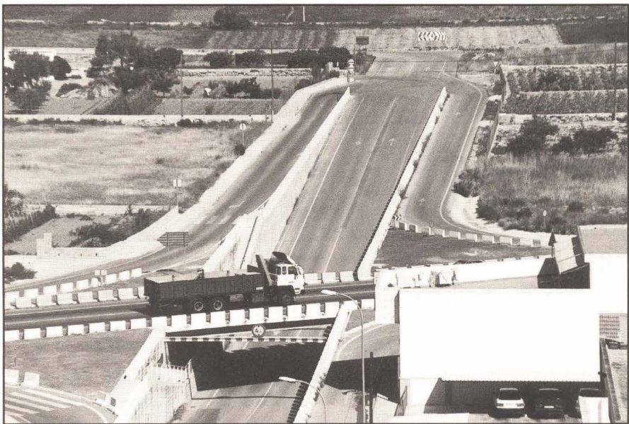
El pas subterràneo necessita una urgente salida hacia la Av. Juan XXIII Foto: A. Alcázar
