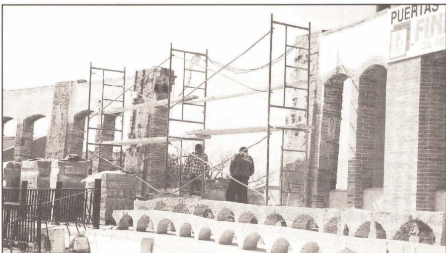
Trabajos realizados por especialistas en obra vista. Foto: Arts
