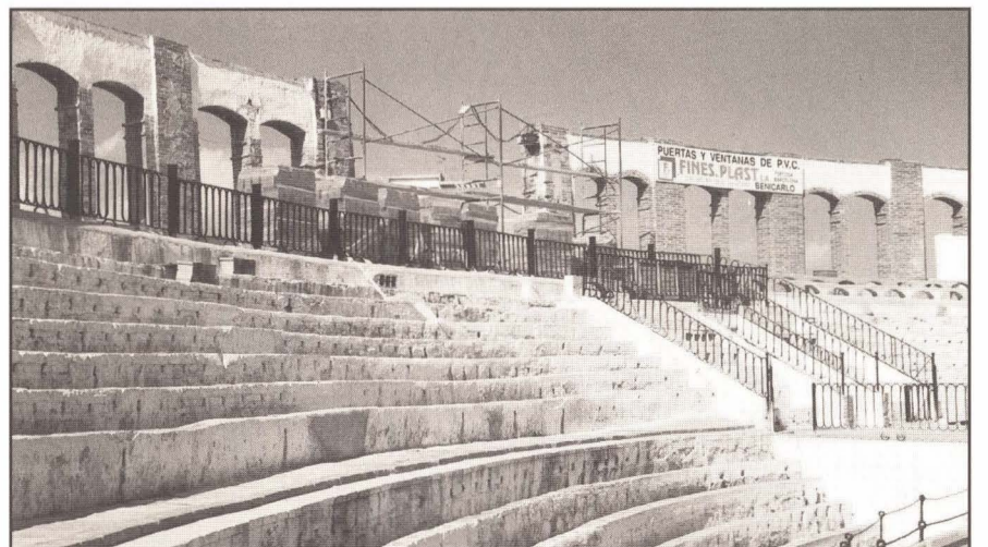
Importantes obras de restauración en la Plaza de Toros. Foto: Arts
