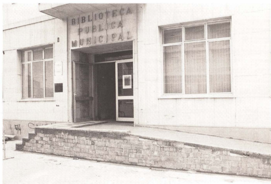
Se ha construido una rampa para acceder a la Casa de la Cultura
