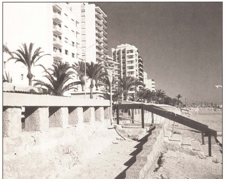
En la Platja del Fortí, la Brigada de obras del Ayuntamiento está mejorando los accesos para los minusválidos. Foto: A. Alcázar
