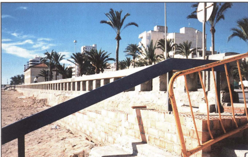
▲ Eliminació de barreres arquitectòniques
