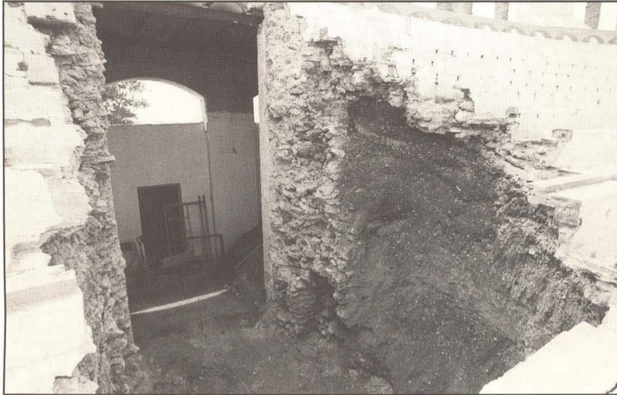
Obras en la plaza de toros. Foto: Difo's
