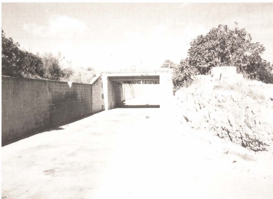
Puente de la RENFE en la carretera de la ermita. Foto: J. Zaragoza
