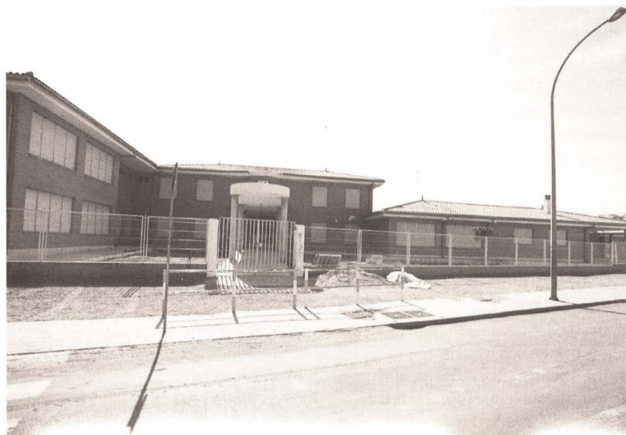
S'estava construint el nou "Sant Sebastià"
