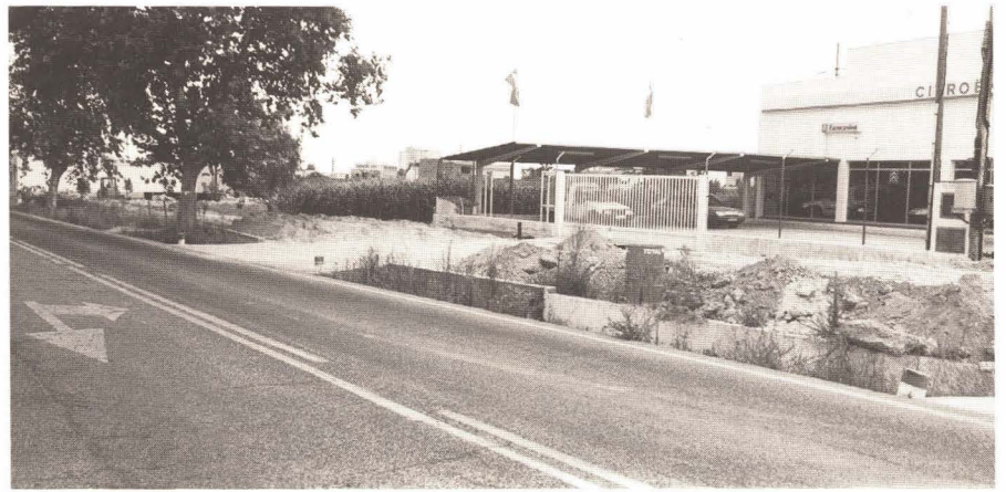
Han començat les obres de la N-232 a l'Avinguda de Saragossa.
