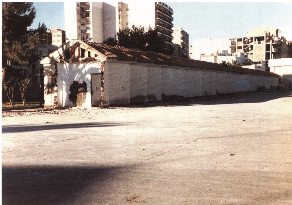
Se ha realizado ya el derribo de las casetas en donde tiene que ubicarse la Casa del Mar. Foto: Reula
