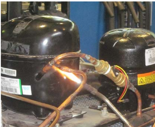
Figura 2-4 sustitución compresor
