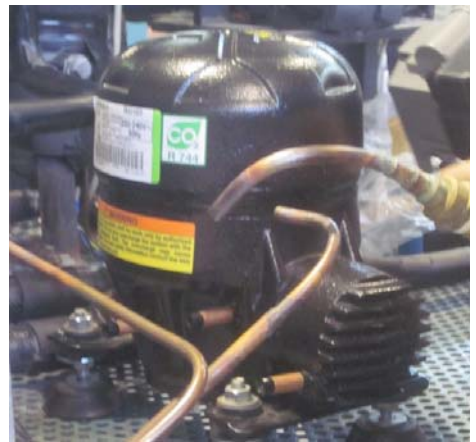
Figura 2-5 Ajuste conexiones para nuevo compresor
