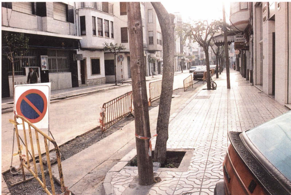
Muy avanzadas las obras de la calle Socorro Foto: Reula
