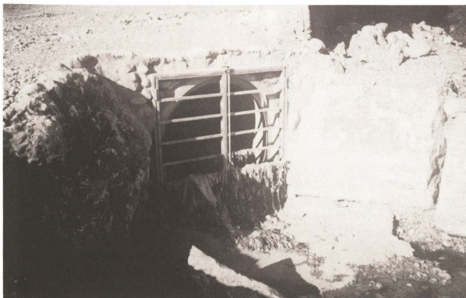
Boca del desagüe del rebosadero
