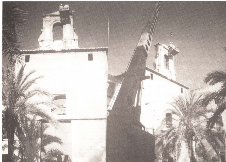
Obras en el ex-convento San Francisco. Imágenes del pasado jueves. Foto: A. Alcázar
