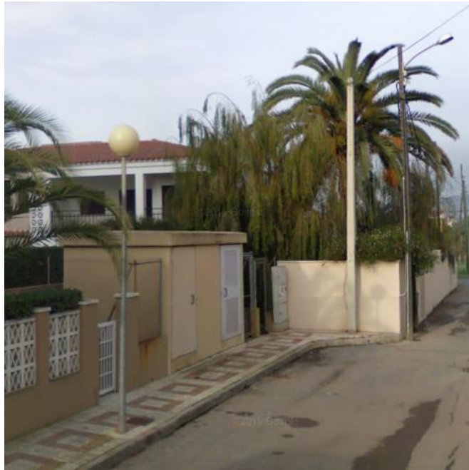
Ilustración 2. Luminarias en Travesía 16
