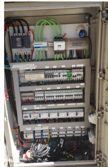
Ilustración 42. Elementos de protección y medida CM 122
