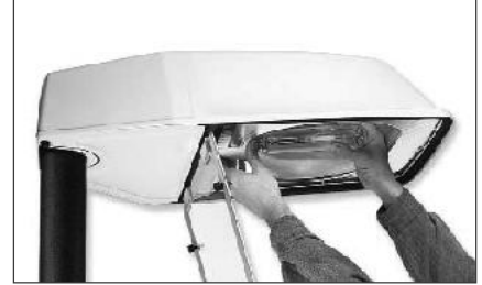
Sustitución lámpara IVA-VS
