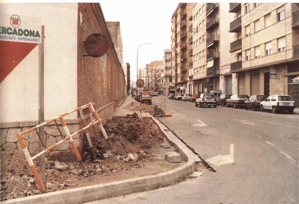
S'estan rematant les voreres del Camí Pont. Foto: Reula
