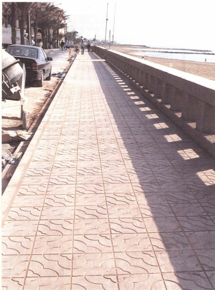
Aspecto de las nuevas aceras del paseo.
