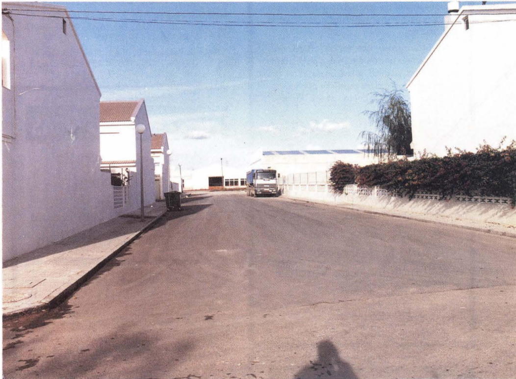
Nueva calle pavimentada. Foto: Reula
