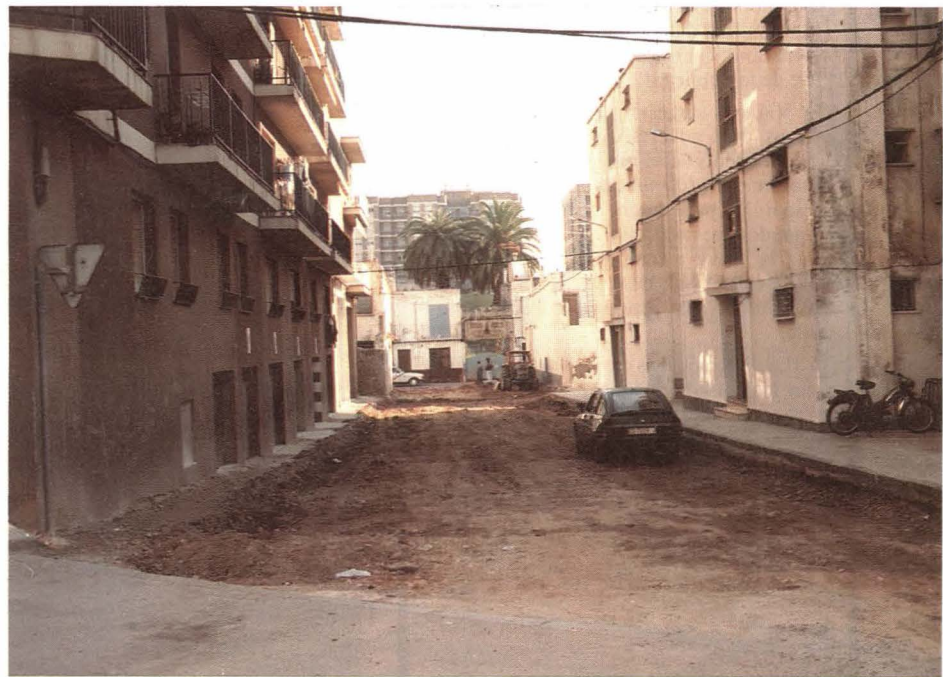
Obras de pavimentación en las calles San Narciso e Historiador Borrás Jarque. Foto: Reula
