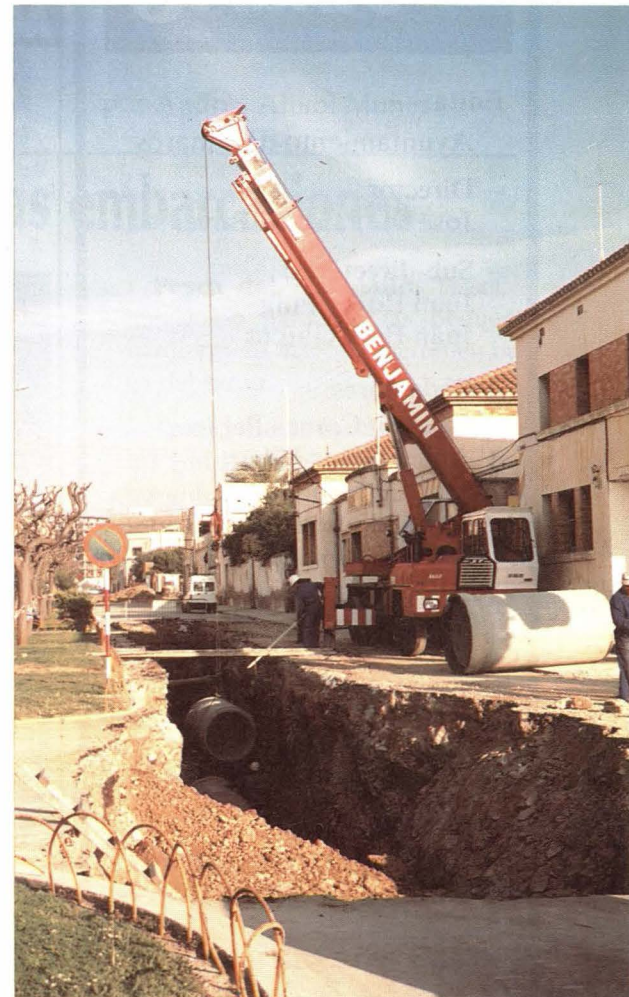
Obras del Colector en Avda. Jaime I. Foto Reula
