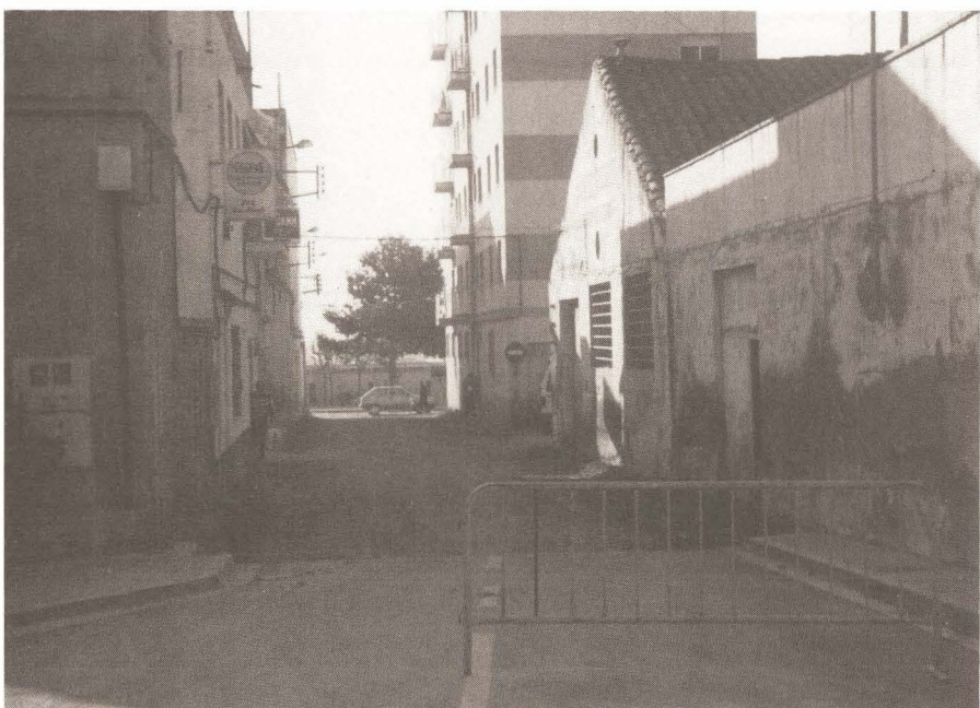
Han començat les obres de pavimentació dels carrers Sant Narcís i Borràs Jarque. Foto: Reula
