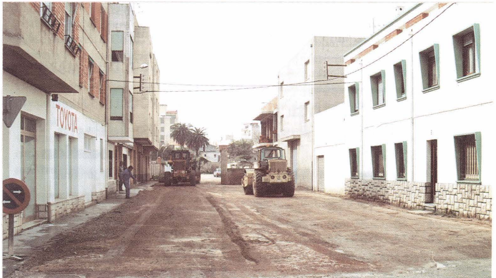
Siguen las obras de adecentamiento de calles. Foto: Reula
