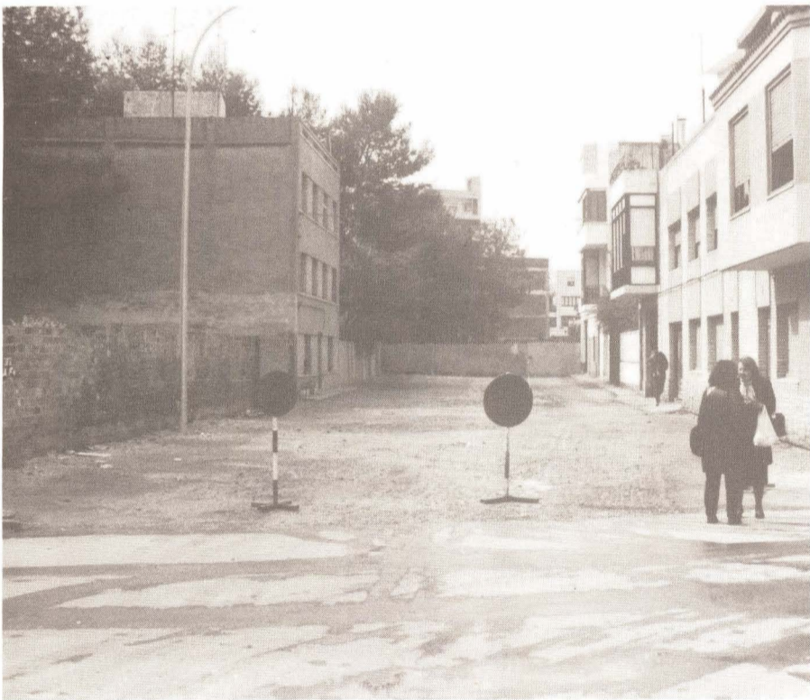
Continua el arreglo y pavimento de calles. Foto: Reula
