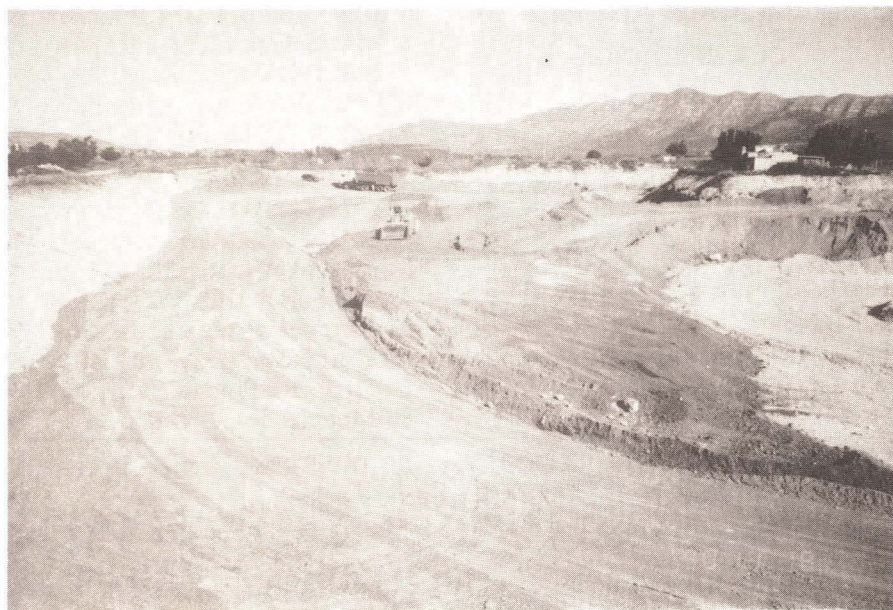
Vista general de la zona ampliada. En primer término la impresionante recta de 14 m. de anchura
