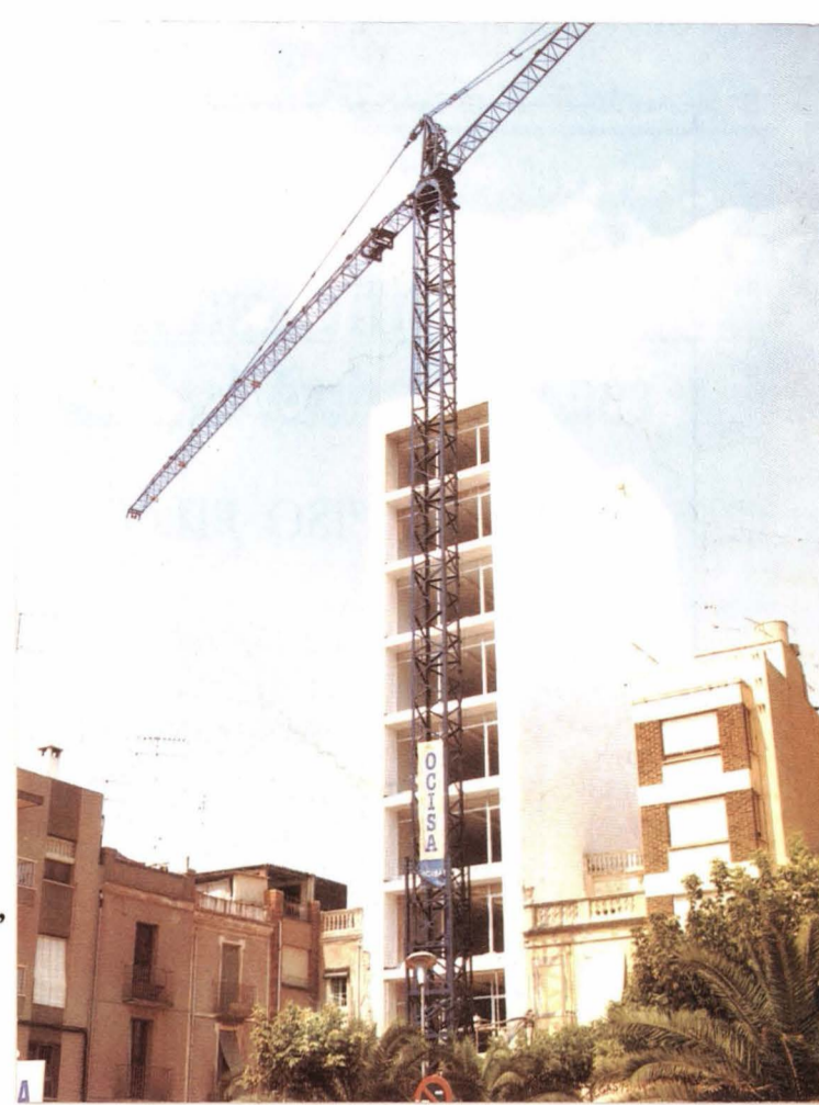
El edificio «Centro Histórico del Maestrat», casi a punto.
