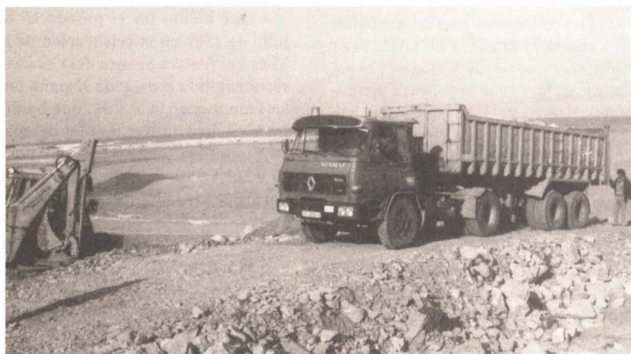
Han empezado las obras de la playa con el fin de solucionar el único «agujero negro», con la construcción de un brazo y acarreo de arena. Foto: Reula
