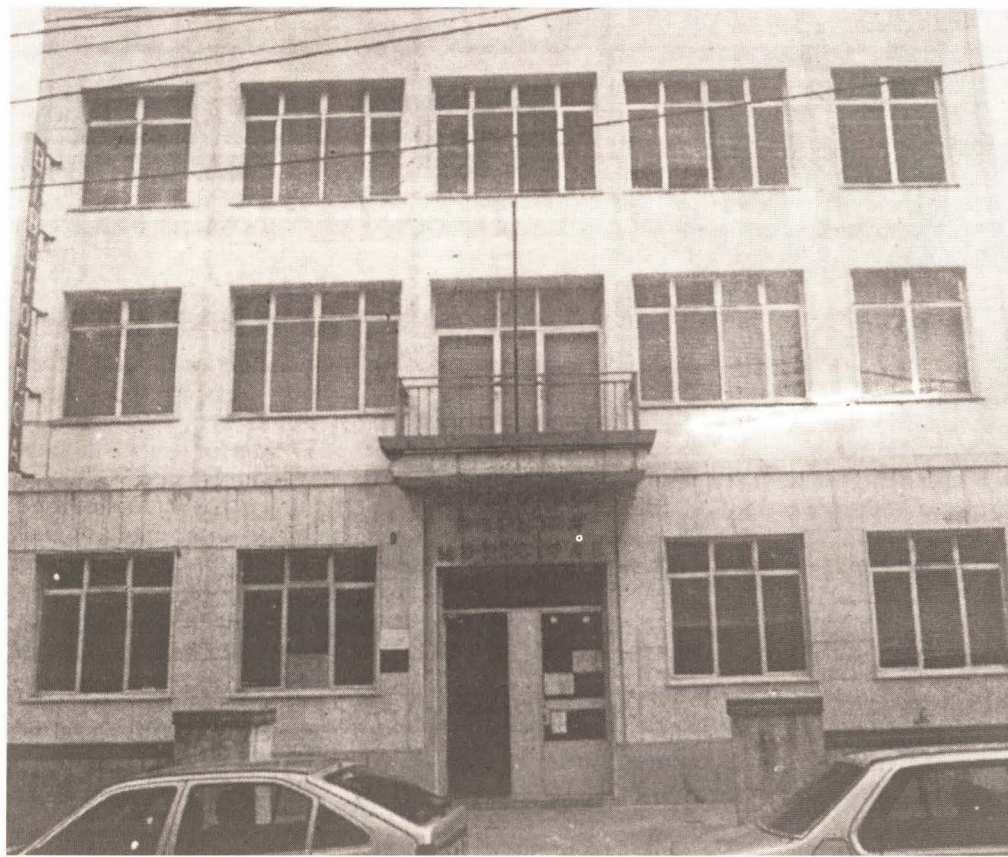
El centro se instalará en esta zona
